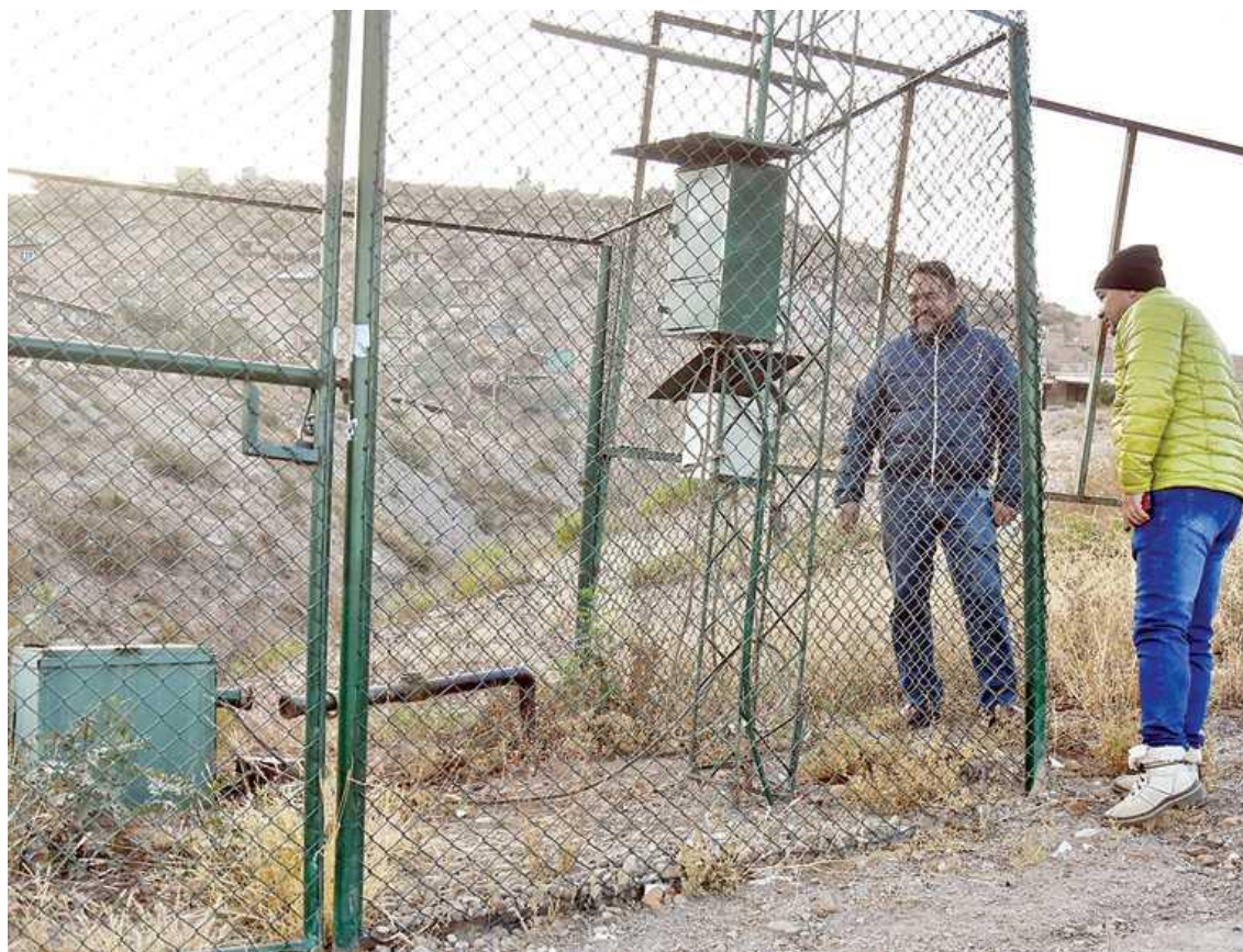
LA BOMBA DE UN POZO QUE NO SE USA EN LA ZONA SUR. MIJAEL RIVERA
