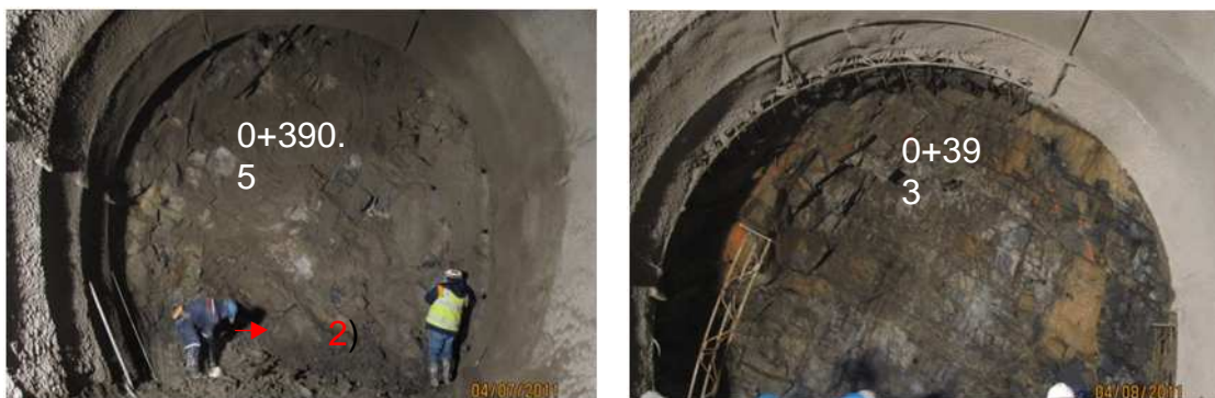
FRENTE ROCOSO EN TERRENO TIPO II
