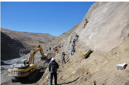
Foto N°38.- Excavación de proxima banquina de 3708 a 3705 y sector con asentamiento
