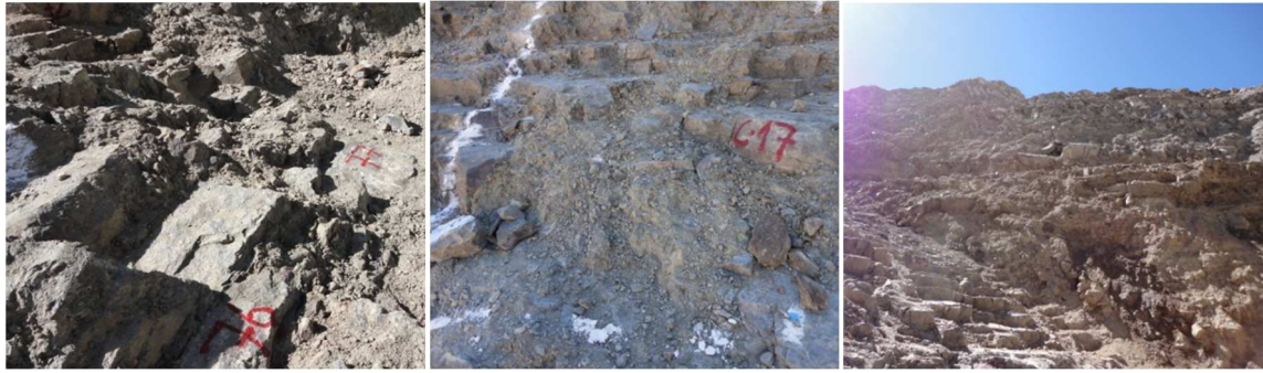
Foto n°21.- Mapeo de Plinto en estribo derecho
