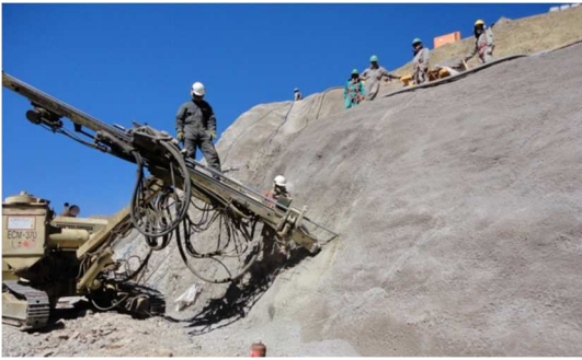
Foto N°36.- Perforación é instalación de Pernos de anclaje
