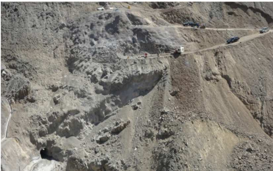
Foto N°37.- Profundización de Talud hasta la 3708 e instalación de Pernos, drenes y malla
