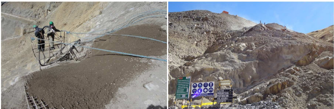
Foto N°32.- Reinicio de actividades en Talud de Portal de Salida
