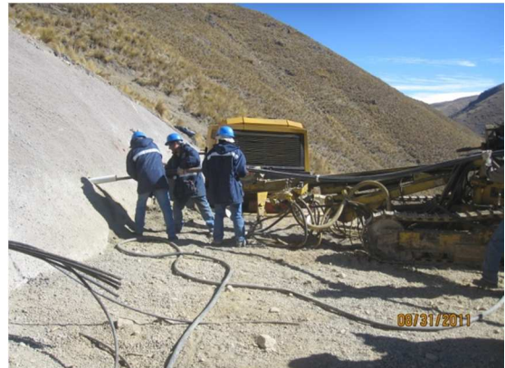
Foto N° 26 Tratamiento de taludes Cortina atirantada
