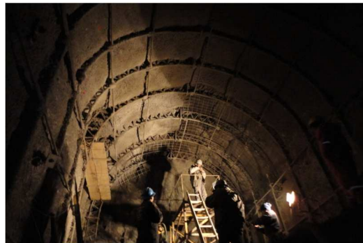
Foto N°15.- Instalación de 8 Cerchas grandes é inicio de la aplicación del hormigón lanzado
