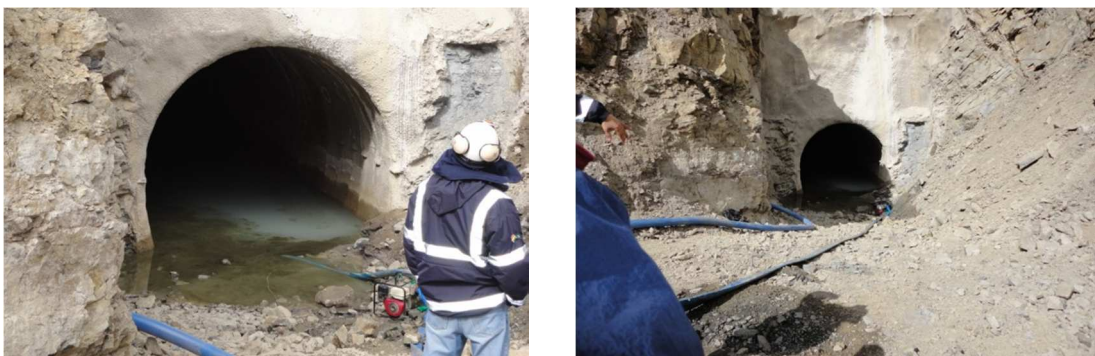
Foto N°33.- Bombeo de agua del Portal de salida
