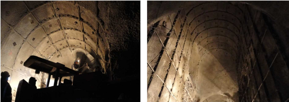
Foto N°17.- Tratamiento en el sector de la bóveda de la Cámara de Válvulas concluida
