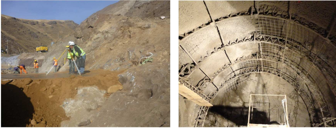
Foto N° 4 Control y replanteo Cámara de válvulas y Ataguía
