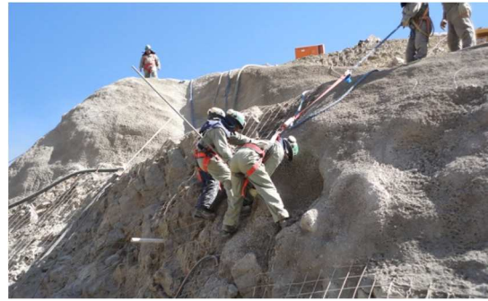
Foto N°36.- Perforación é instalación de Pernos de anclaje
