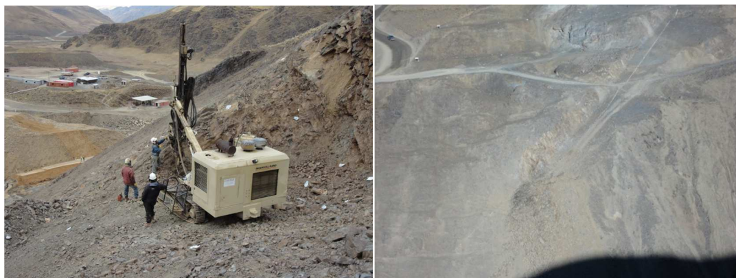
Foto N°20.- Excavaciones en Plinto. Estribo izquierdo
