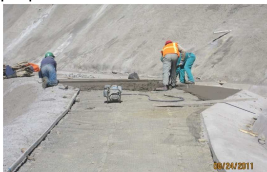
Foto N° 28 Mortero de cemento para protección de taludes.
