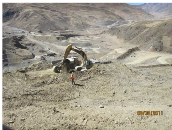
Foto N° 24 Excavación en Banquinas.
