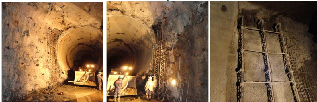
Foto N°11.- Instalación de 3 primeras Cerchas en los hastiales
