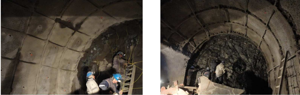
Foto N°16.- Regularización del macizo e instalación de Cerchas de los extremos
