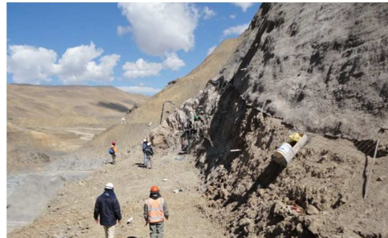
Foto N°37.- Profundización de Talud hasta la 3708 e instalación de Pernos, drenes y malla
