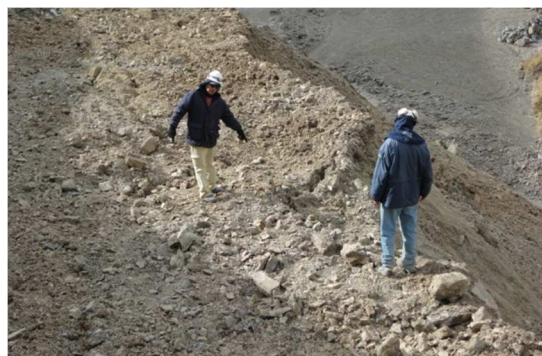
Foto N°38.- Excavación de proxima banquina de 3708 a 3705 y sector con asentamiento
