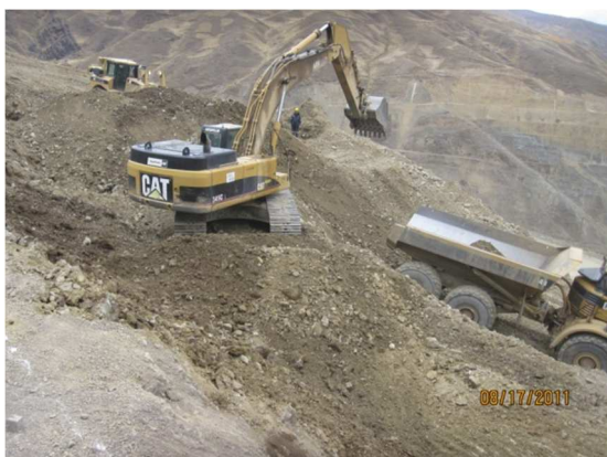
Foto N° 24 Excavación en Banquinas.
