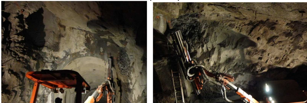
Foto N°10.- Excavaciones en parte superior de Cámara de Válvulas
