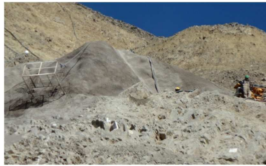
Foto N°34.- Tratamiento de Talud en Portal de salida a
