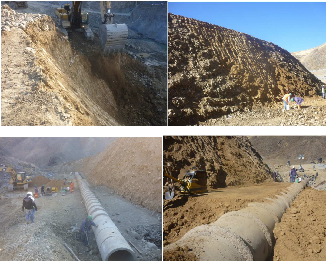
Foto Nº 41 Nivel Ataguía Estribo Izquierdo
