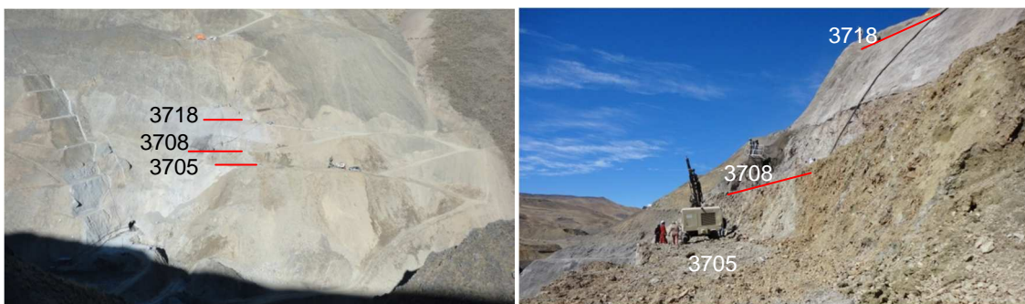
Foto N°39.-Perforación de huecos para pernos y aplicación de hormigón lanzado
