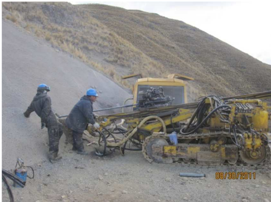
Foto N° 26 Tratamiento de taludes Cortina atirantada
