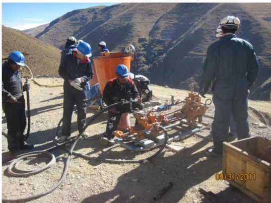
Foto N° 27 Inyección de Mortero para el anclaje de los torones
