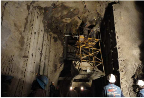
Foto N°14.- Cargado en bóveda para voladura y Primer arco de Cercha instalado
