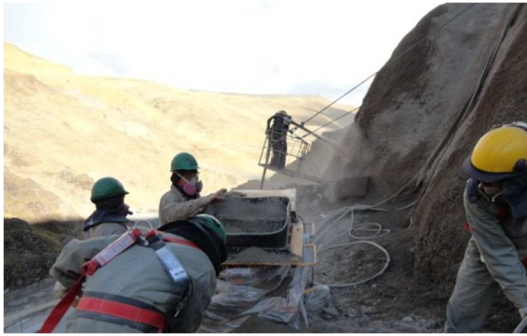
Foto N°34.- Tratamiento de Talud en Portal de salida a
