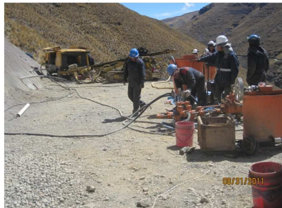
Foto N° 27 Inyección de Mortero para el anclaje de los torones
