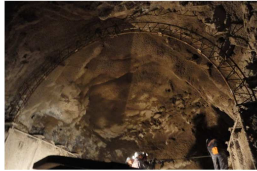
Foto N°14.- Cargado en bóveda para voladura y Primer arco de Cercha instalado
