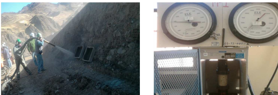
Foto nº 9 Preparado y Lanzado de Hormigón Proyectado Vía Seca
