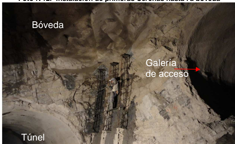
Foto N°12.- Instalación de primeras Cerchas hasta la bóveda
