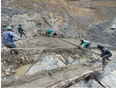
Foto 5: Hormigonado de tramo liberado
