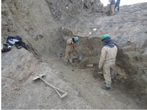
Foto 3: Excavación para llegar a cotas de diseño
