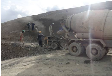
Foto 1: Protección del talud con hormigón proyectado
