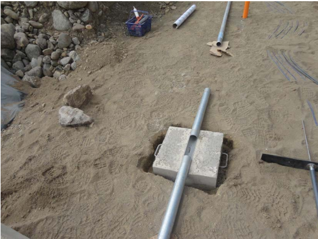
Instalación de línea 3720 de celdas de Asentamiento y extensómetros de HV.
