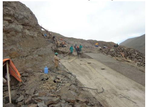
Foto 6: Tramo concluido con hormigón de regularización
