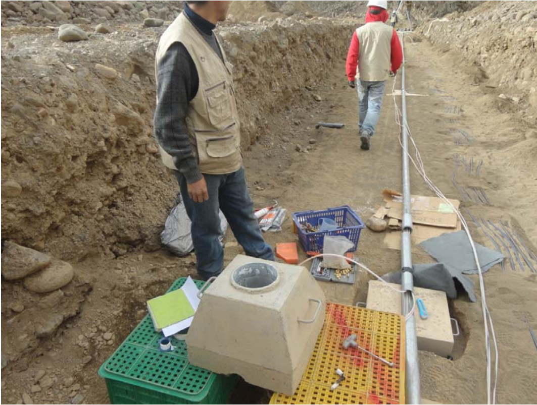
Instalación de línea 3720 de celdas de Asentamiento y extensómetros de HV.
