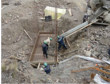
Foto 5: Hormigonado losas de la cabina CL-07
