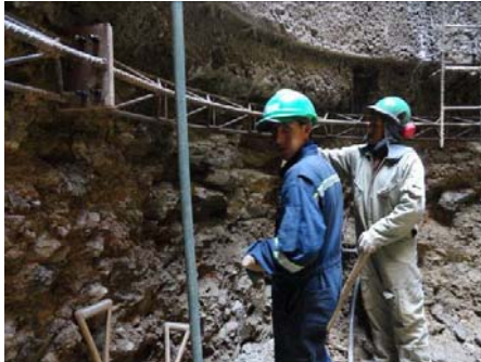
Foto 3: Instalación de una cercha reticulada
