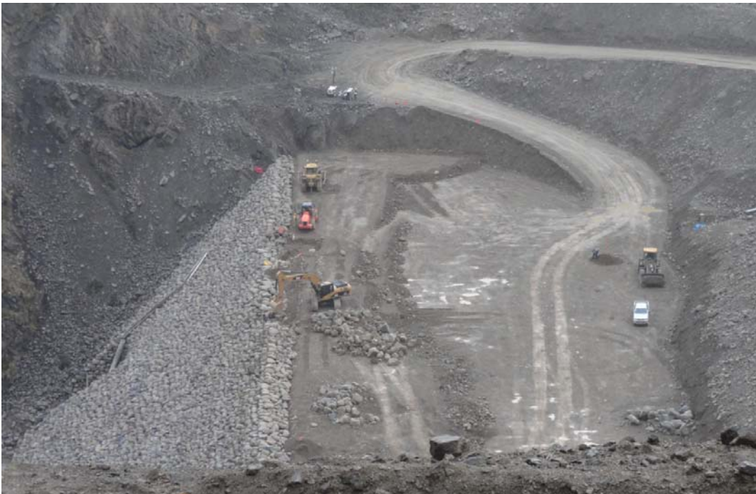
Colocado del Enrocado de protección.
