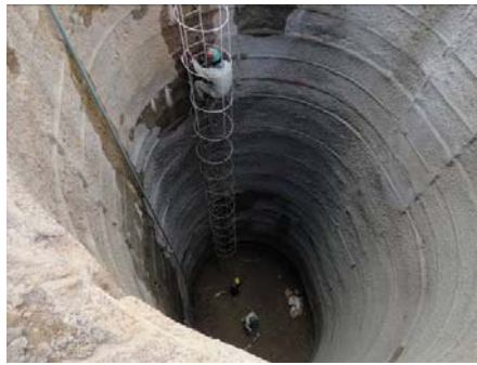
Foto 3: Instalación de una cercha reticulada
