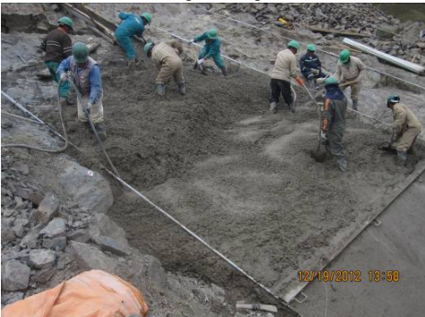
Foto 5: Vibrado del hormigón de regularización
