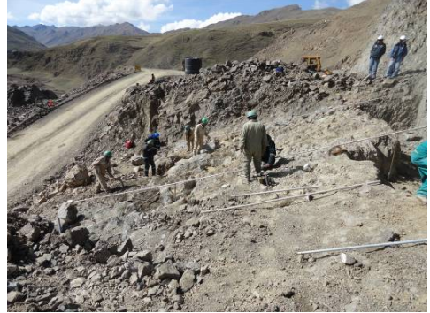
Foto 4: Plinto lavado con agua y aire a presión
