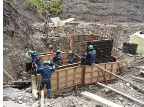
Foto 6: Encofrado de muros cabina CL-07
