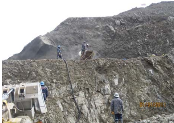
Foto N°20.- Aplicación de hormigón lanzado en Talud 3700-3690
