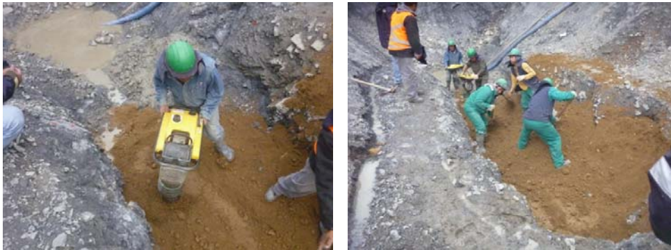
Foto N° 22 Compactado Material 1-A (Ataguía)
