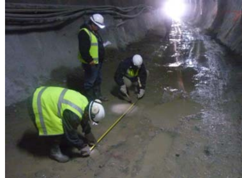
Foto N° 5 Replanteo Túnel
