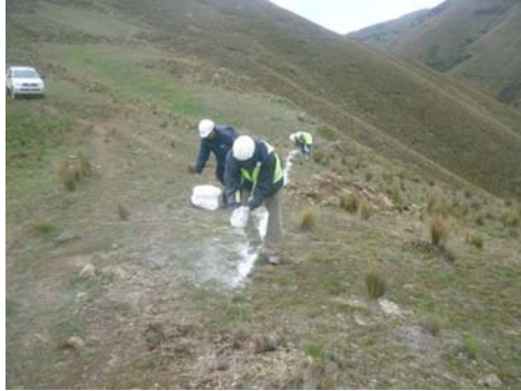
Foto N° 4 Replanteo Estribo Izquierdo
