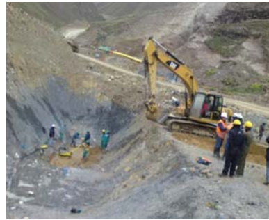
Foto N° 7 Verificación del Emplazamiento (Ataguía)
