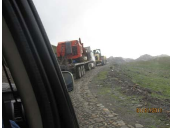
Foto N°14.- Transporte de Equipo de Perforación Marca TAMROCK.
