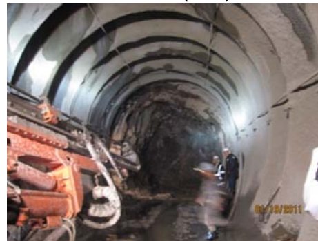
Foto N° 12 Perforacion Jumbo (Tunel)
