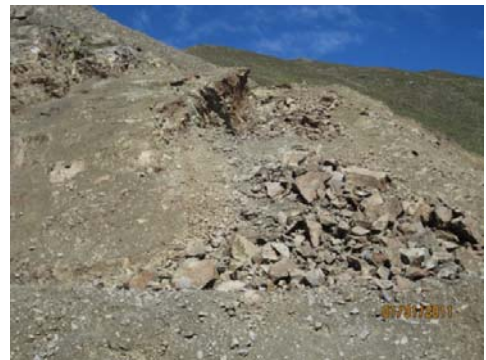
Foto N°18.- Desprendimientos en Portal de entrada
