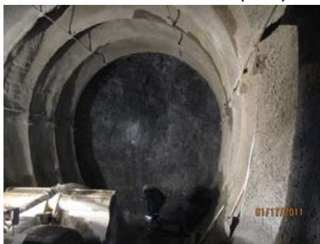
FotoN° 11 colocado de Cerchas(Tunel)
