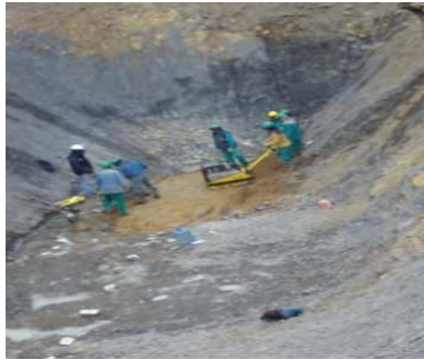
Foto N° 6 Tendido y compactado (Ataguía)
