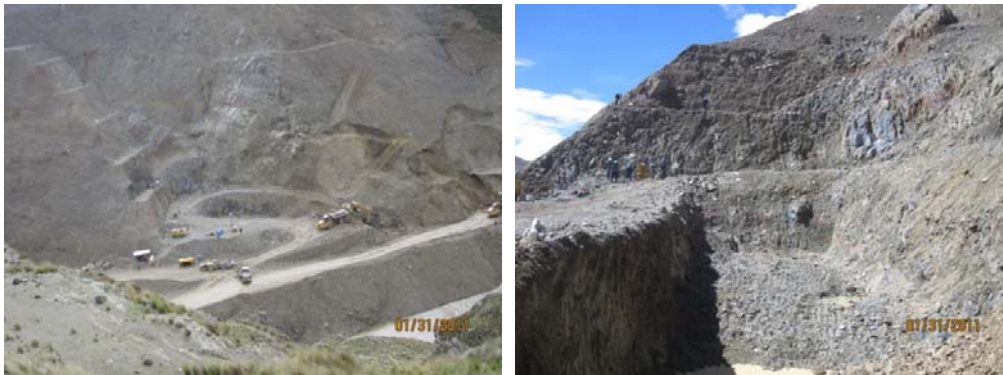
Foto N°21.- Excavación de canal al Portal de salida
