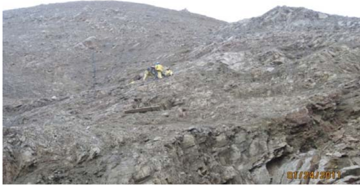
Foto N°20.- Aplicación de hormigón lanzado en Talud 3700-3690
