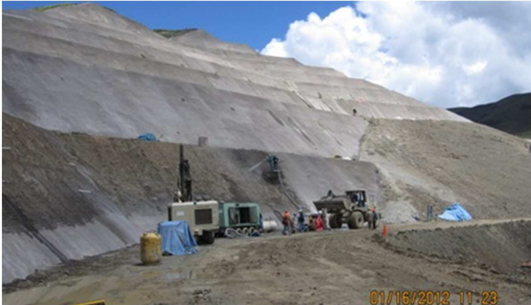
Estribo Izquierdo Taludes Adyacentes al Vertedero (Cortina Atirantada)
