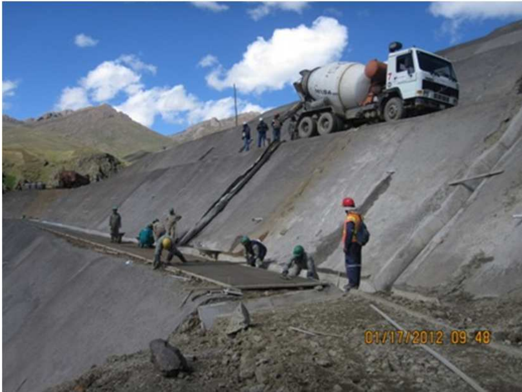
Vaciado de losa de mortero de cemento en banquetas 3815
