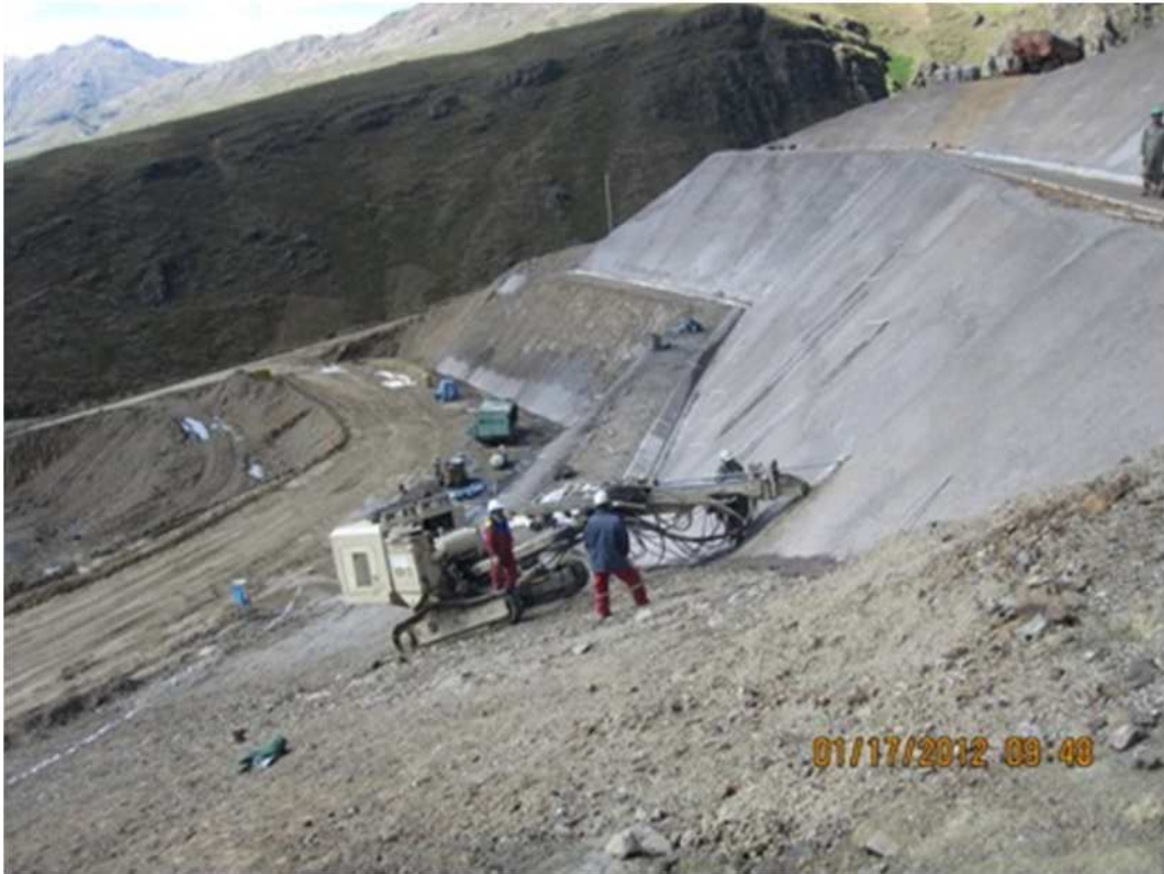
Perforación y colocación de DHPs entre cotas 3800 a 3795.
