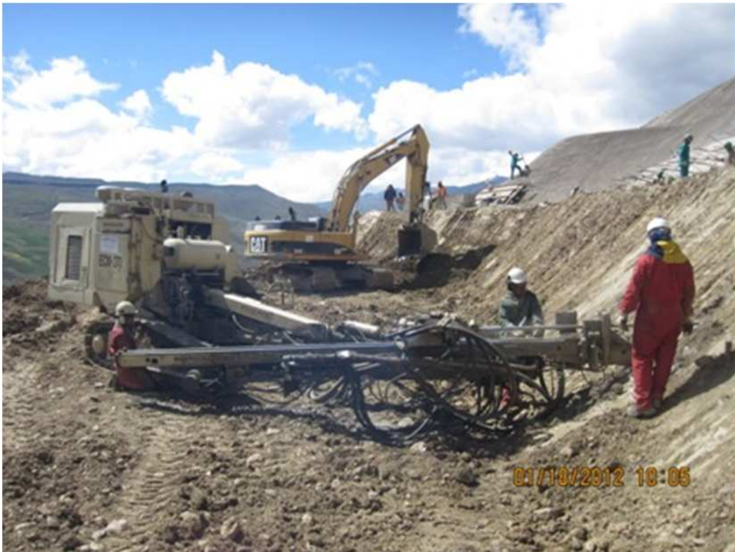
Perforación y colocación de DHPs entre cotas 3800 a 3795.
