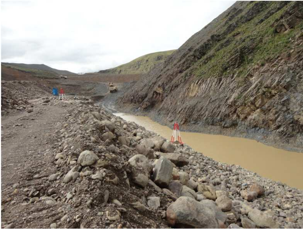
Corte de material suelto, talud de material conformado de la Presa. 31-01-2012
