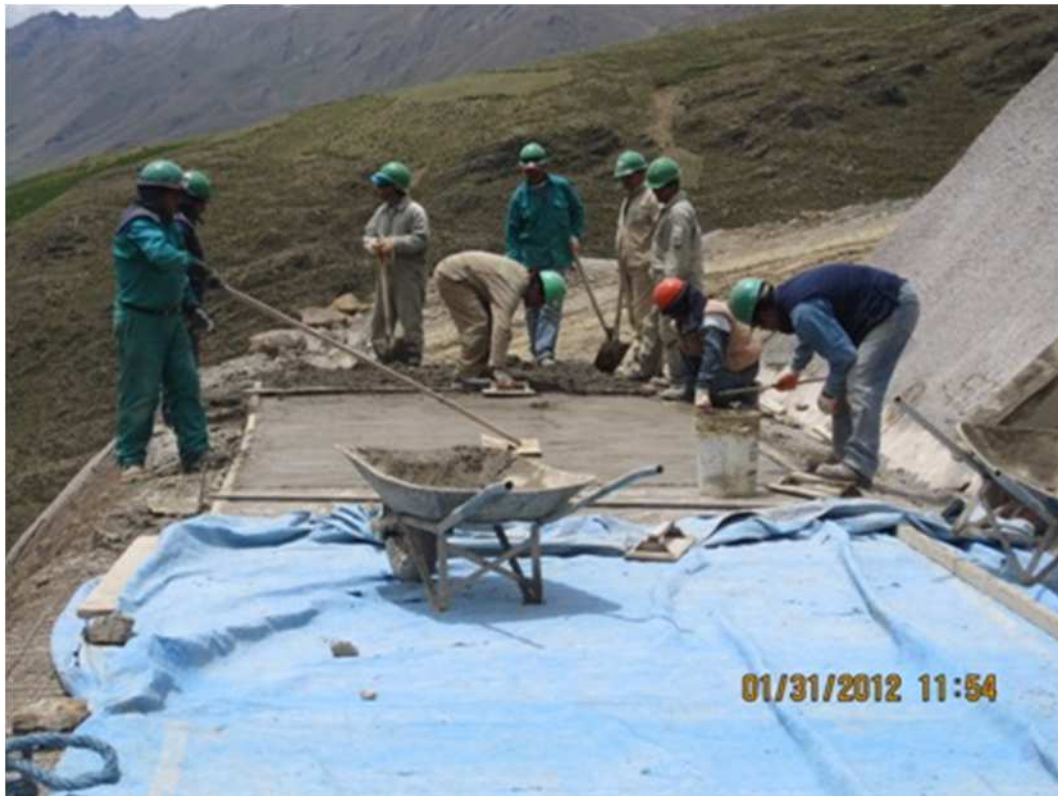
Vaciado de losa de mortero de cemento en banquetas 3815
