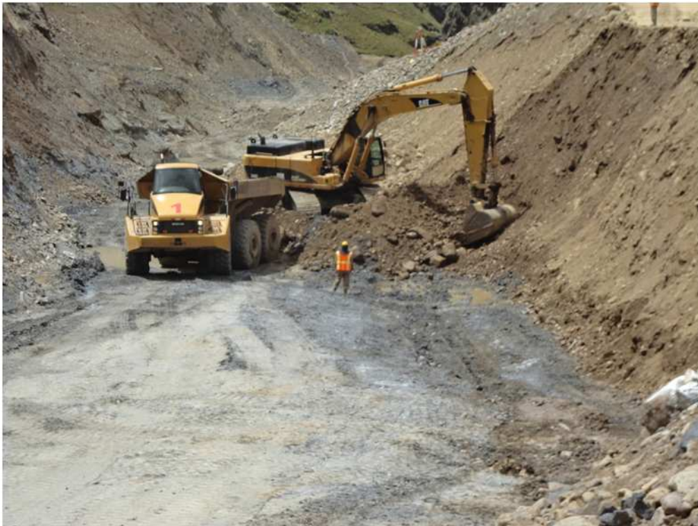
Corte de material suelto, talud de material conformado de la Presa. 31-01-2012
