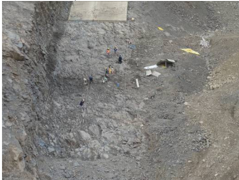
Foto 5: Perforación para voladura - cota 3666
