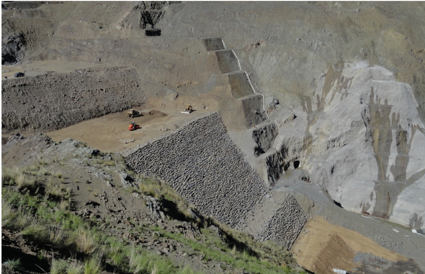
Vista Presa Aguas Abajo
