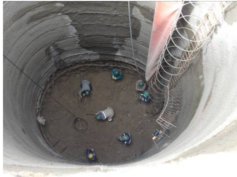
Foto 3: Instalación de cerchas reticuladas - vista en planta
