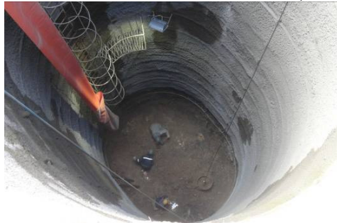
Foto 3: Instalación de cerchas reticuladas - vista en planta
