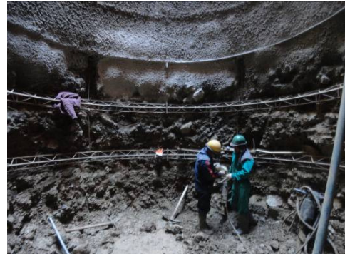
Foto 4: Instalación de cerchas reticuladas
