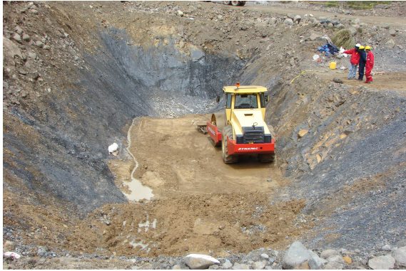
Excavación y Relleno Ataguía Aguas Arriba
