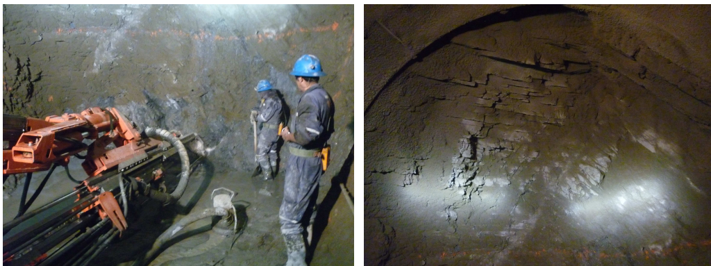
Excavaciones y Sostenimiento Túnel de Desvío
