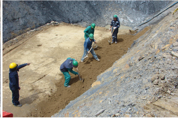
Excavación y Relleno Ataguía Aguas Arriba
