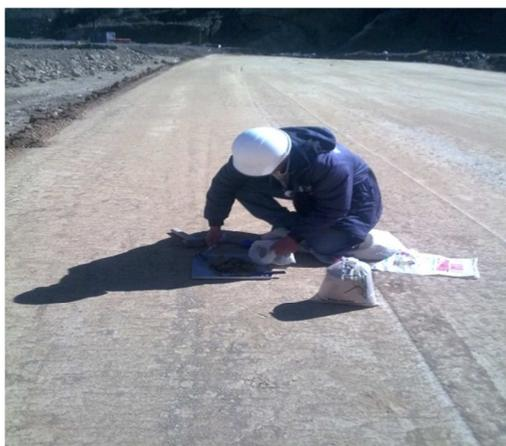
Foto N° 13 Compactado Núcleo de la Ataguía
