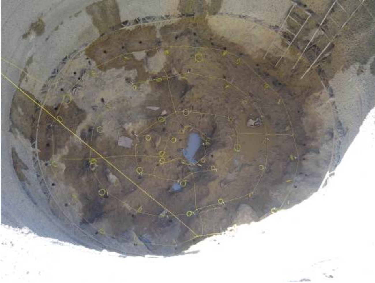
Pozo de Compuertas BOCATOMA
