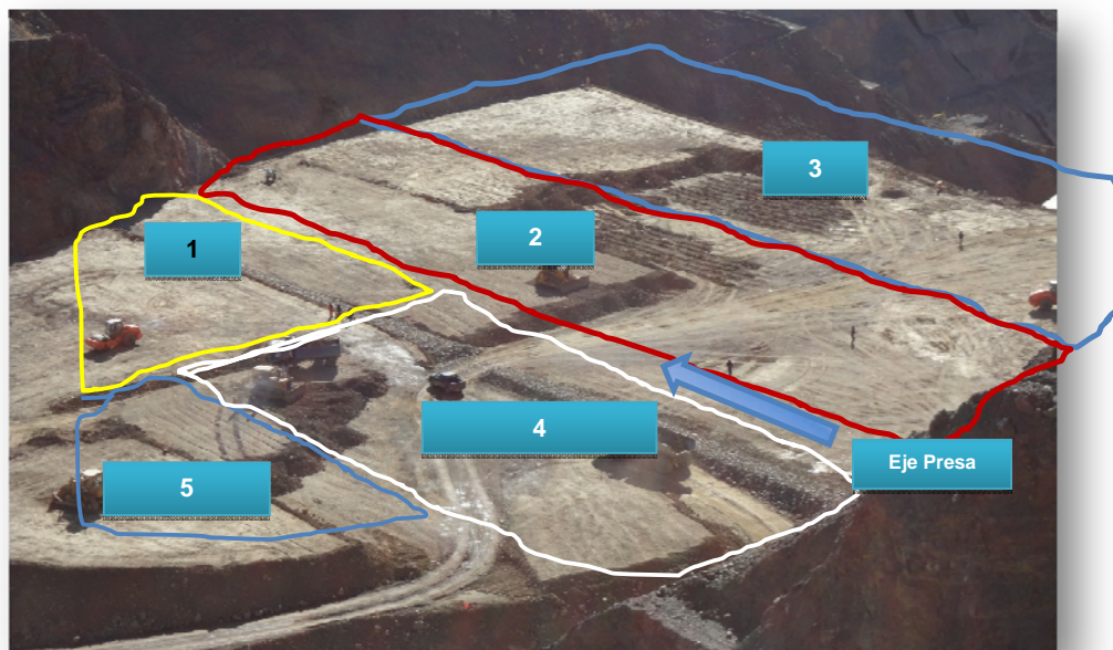
Vista panorámica del sector de rellenos de la Presa. 28-07-
