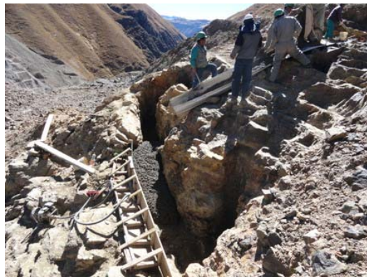
Vaciado de hormigón dental clase K en falla E 2
