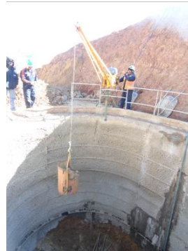
Foto : Protección inicial con hormigón proyectado
