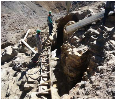
Vaciado de hormigón dental clase K en falla E 2
