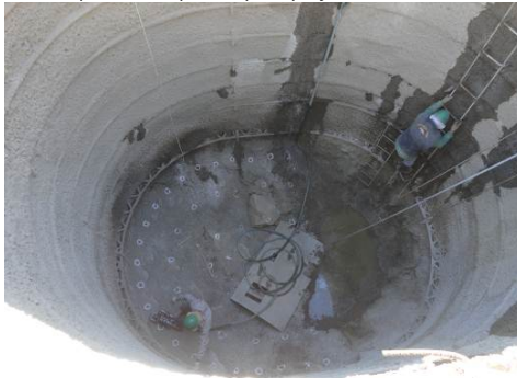
Foto : Replanteo de puntos para perforaciones de voladura
