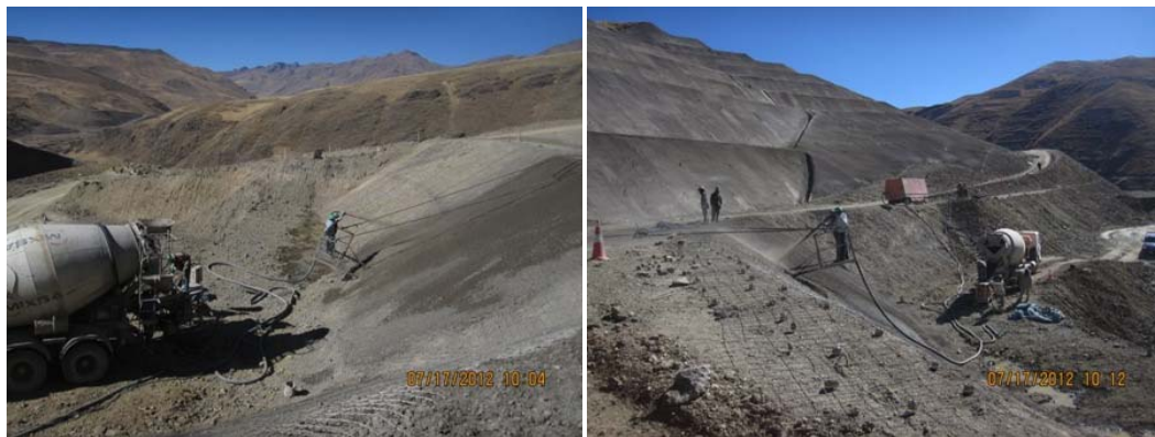
Hormigón Projectado en Banquinas Adyacentes al vertedero.
