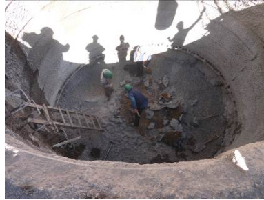
Foto : Retiro de rebote shotcrete
