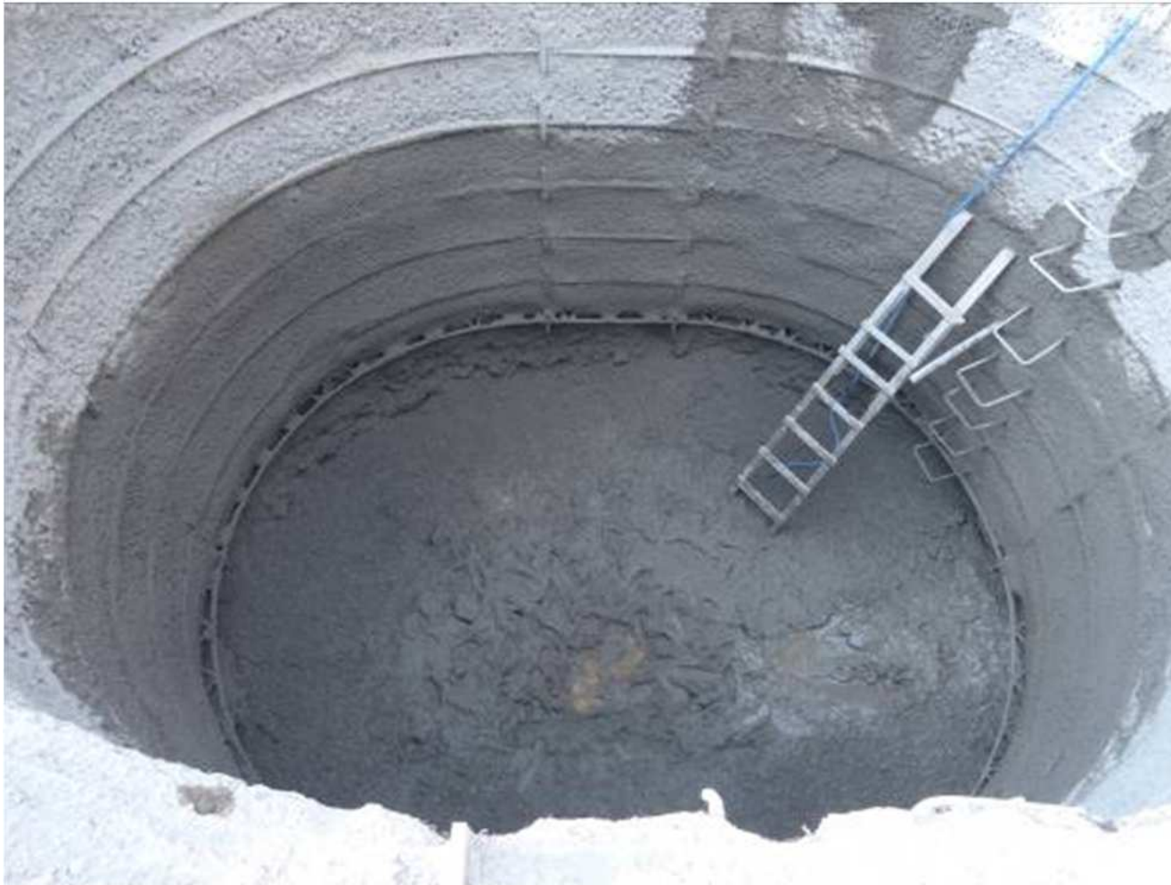
Pozo de Compuertas BOCATOMA
