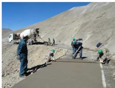
Vaciado de losa de mortero de cemento sobre banquina 3795
