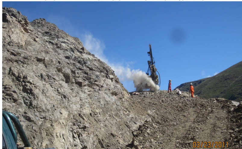
FOTO N°22.- PERFORACIÓN EN ESTRIBO IZQUIERDO
