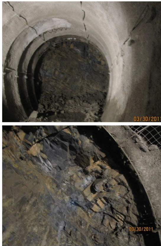
FOTO N°17.- FRENTE ROCOSO EN PROGRESIVA 0+379 (30/0 3)11
