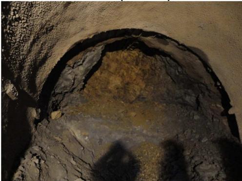
FOTO N°13.- FRENTE TIPO III, CON SPILLINGS EN BÓVEDA
