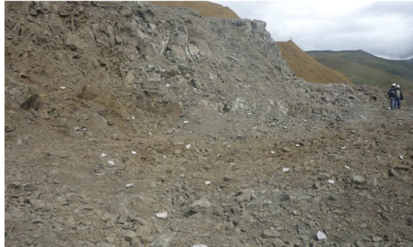
Foto Nº 2 Estacado y marcación Banquina cota 3680
