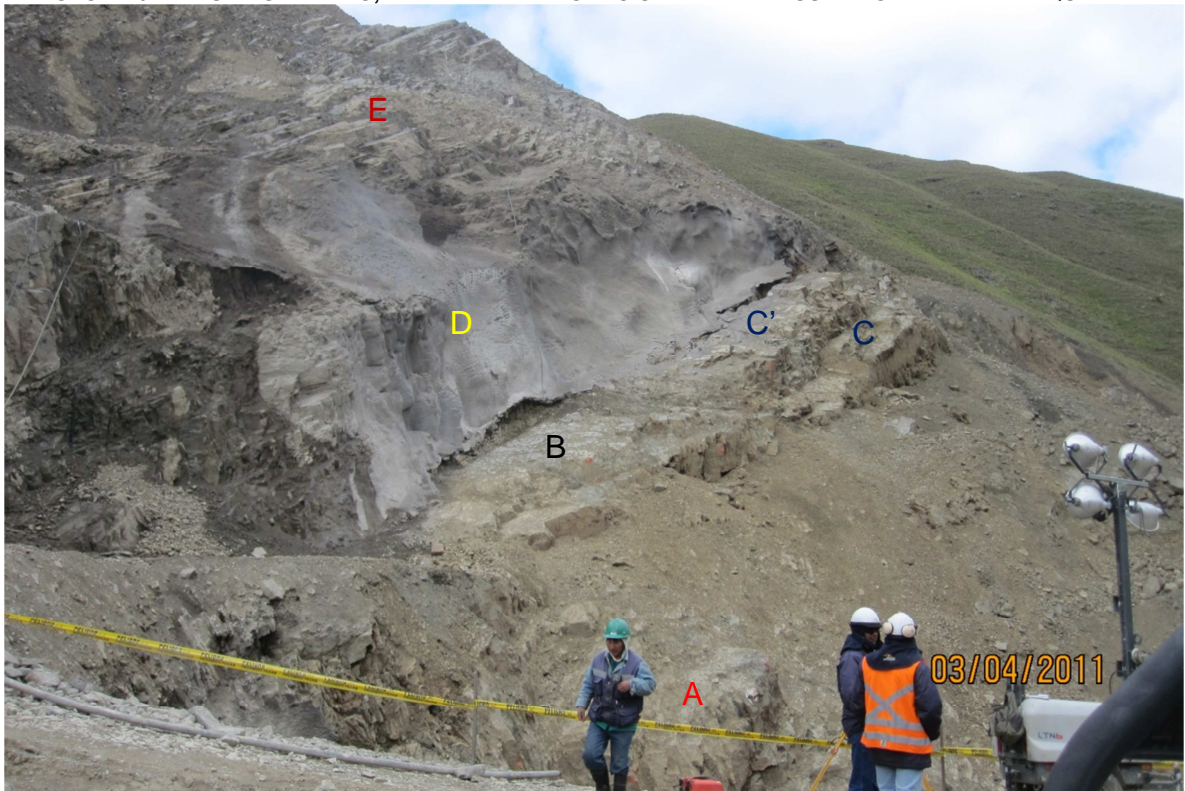
FOTO N°26.- TALUD AGRIETADO, LIMPIEZA Y PERFORACIÓN EN PARTE SUPERIOR DE PARED IZQUIERDA
