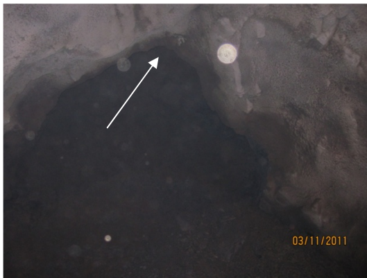
FOTO N°11.- PROGRESIVA 0+335, SOBRE EXCAVACIÓN EN B ÓVEDA DERECHA. TIPO III
