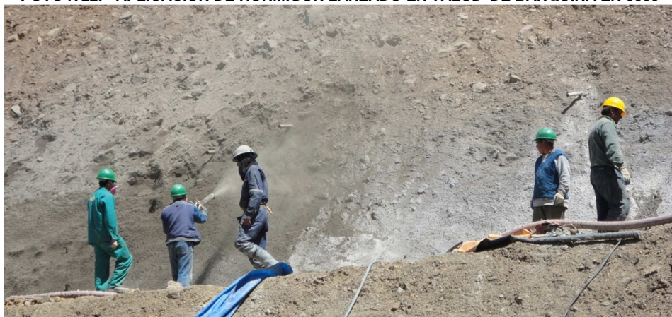
FOTO N°22.- APLICACIÓN DE HORMIGÓN LANZADO EN TALUD DE BANQUINA EN 3835
