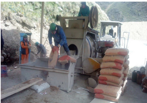
FOTO N 4 MEZCLADO DE HORMIGÓN VÍA SECA
