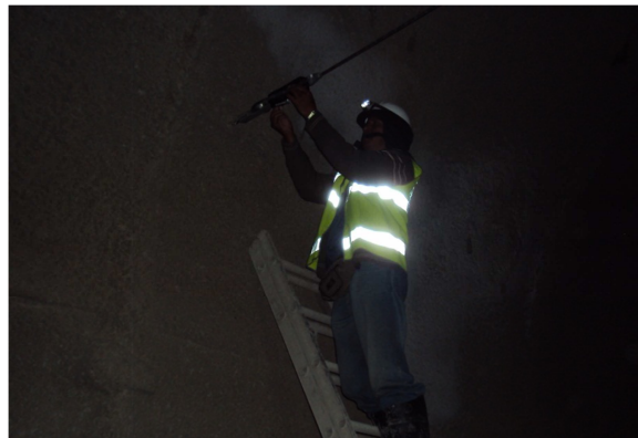
FOTO Nº 3 RELEV. TOPOGRÁFICO TÚNEL DESVIACIÓN
