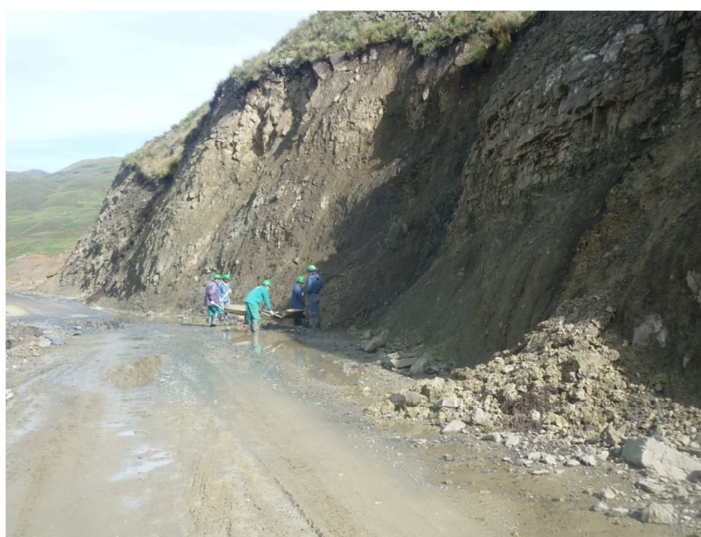
FOTO. 20 LIMPIEZA DE CUNETAS
