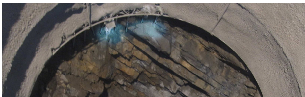
Foto N°16.- Frente rocoso en Progresiva 0+377 (29/03/11).
