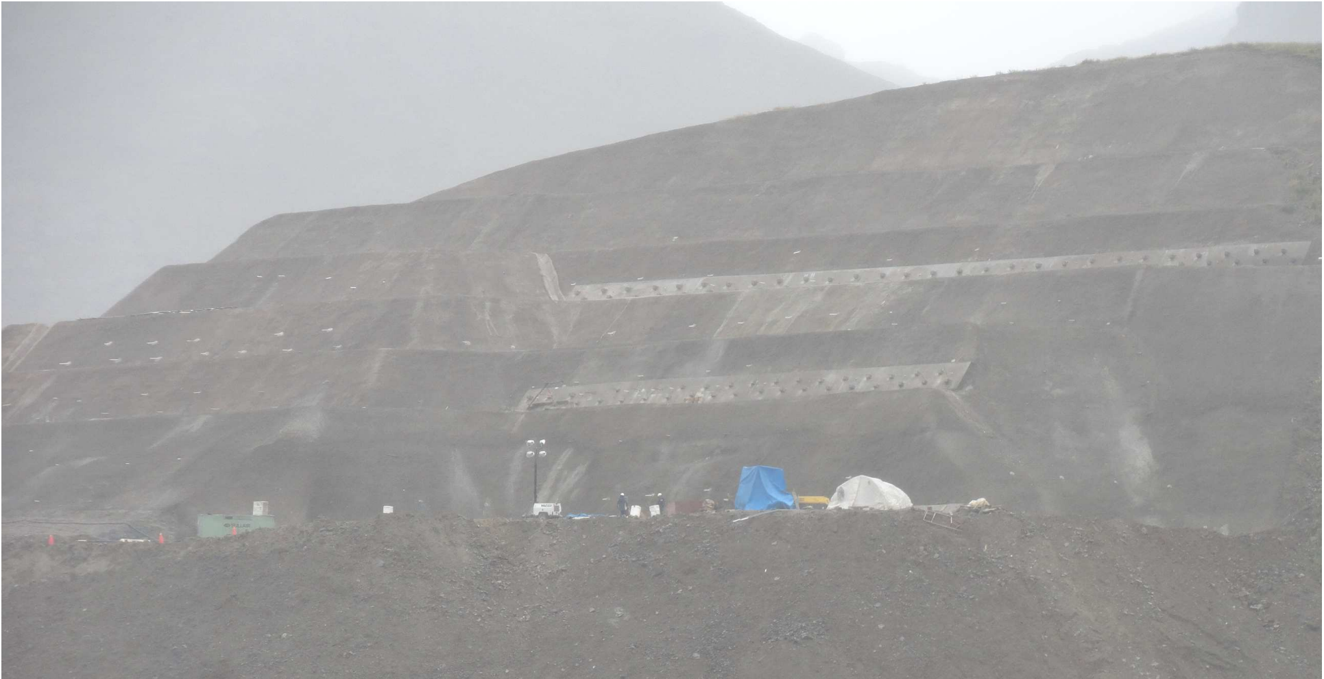
Estribo Izquierdo Taludes Adyacentes al Vertedero (Cortina Atirantada)
