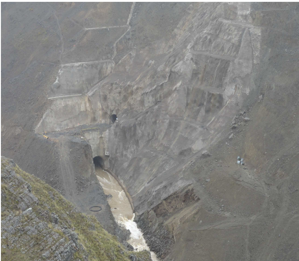
Portal de salida Túnel de Desviación
