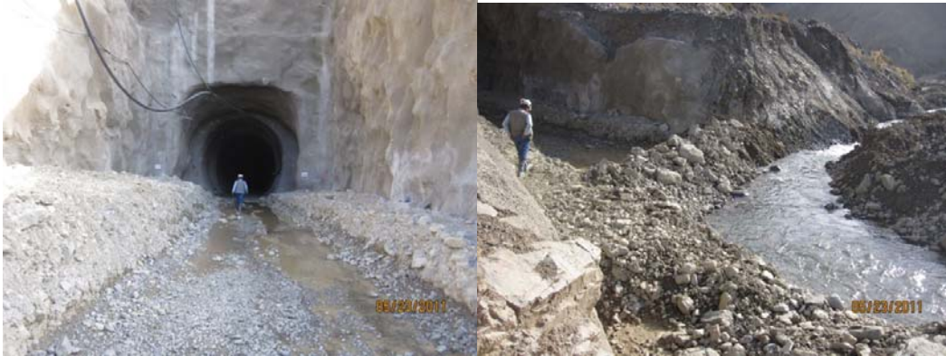
FOTO 32. RÍO DESVIADO A SU CAUCE ORIGINAL, SECTOR PORTAL DE ENTRADA.
