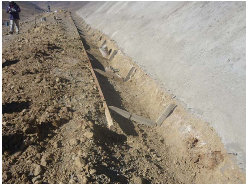
FOTO 3 CUNETAS ESTRIBO IZQUIERDO
