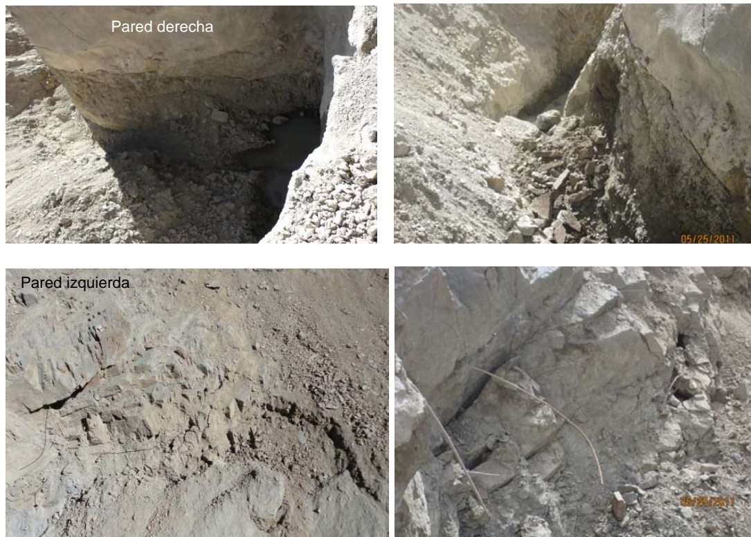
FOTO 34. PAREDES DEL CANAL LUEGO DEL DESVÍO DEL RÍO
