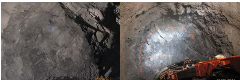
FOTO 24.- FRENTE ROCOSO PAQUETES DE LIMOLITAS CON CAPAS DE ARENISCA CUARCÍTICA
