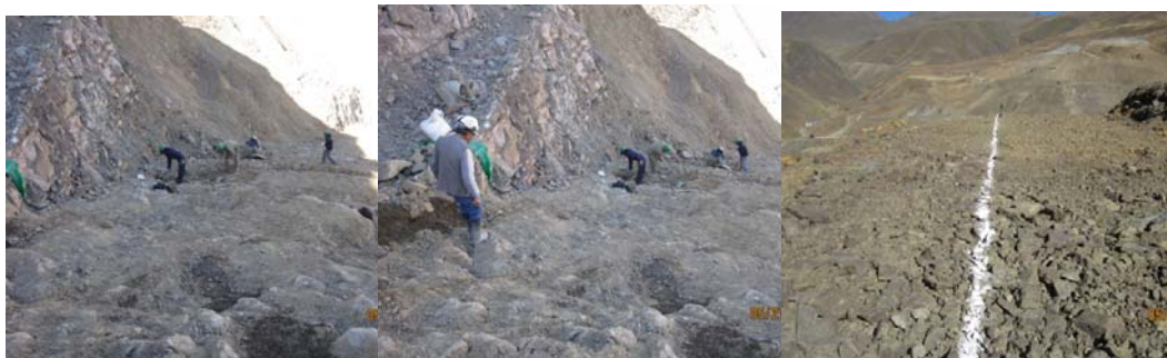
FOTO 27.- LIMPIEZA MANUAL DE TALUD DE PLINTO EN EL ESTRIBO DERECHO
