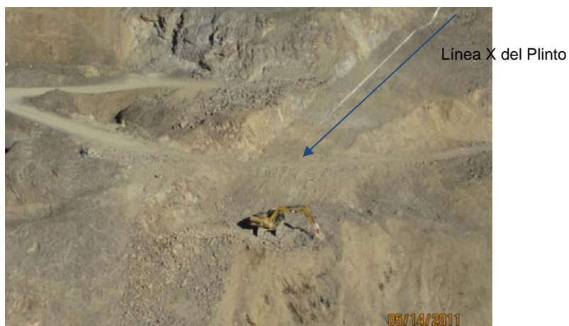
FOTO 28.- EXCAVACIONES EN EL SECTOR DEL PLINTO, ESTRIBO IZQUIERDO
