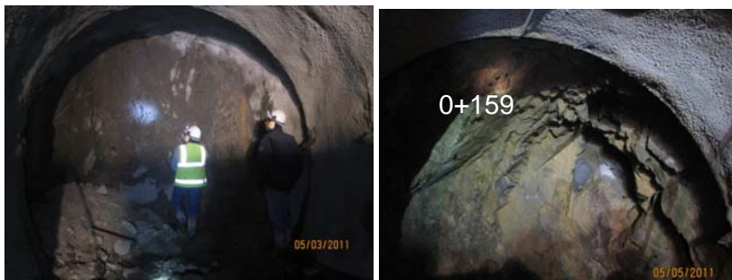
FOTO 18. FRENTE DE GALERÍA EN TERRENO TIPO III
