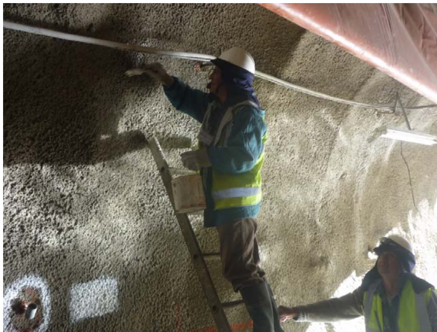
FOTO 5 MARCADO DE ARGOLLAS PARA MEDICIÓN DE CONVERGENCIAS
