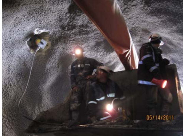
FOTO 22.- PRUEBAS DE EXTRACCIÓN DE PERNOS CON GATO HIDRÁULICO.
