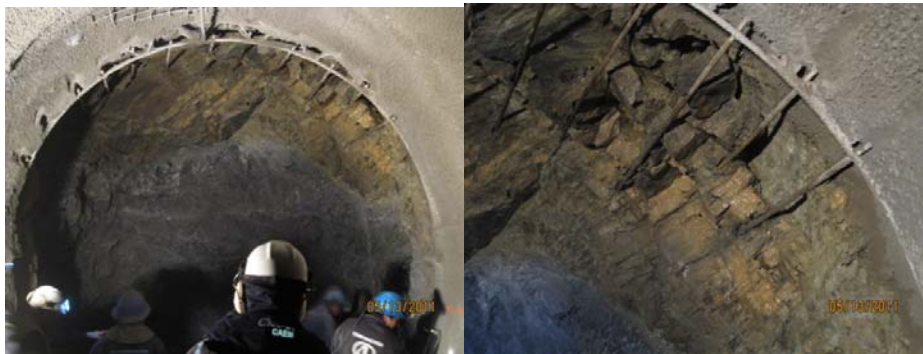
FOTO 20.- CONTACTO ENTRE UN MATERIAL ROCOSO Y UNO MÁS ALTERADO Y MILONITIZADO
