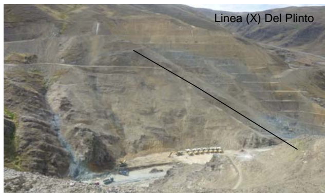
FOTO 26.- UBICACIÓN DEL PLINTO EN EL ESTRIBO DERECHO.
