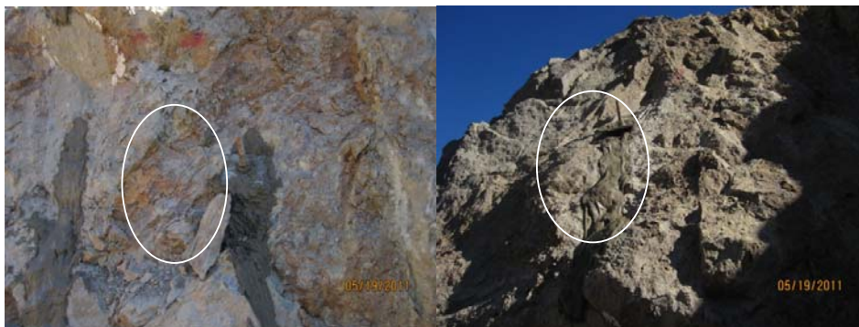
FOTO 33.- INSTALACIÓN DE LOS DOS ÚLTIMOS PERNOS EN LA COTA 3720
