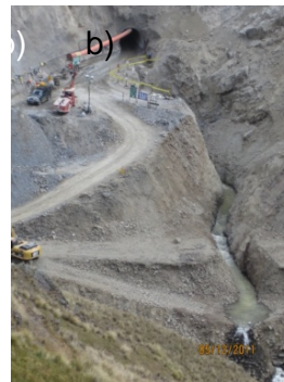
FOTO 31. DESVÍO DEL RÍO A TRAVÉS DEL TÚNEL
