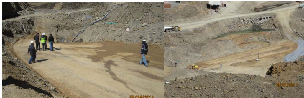
FOTO 37. CONSTRUCCIÓN DE ATAGUÍA
