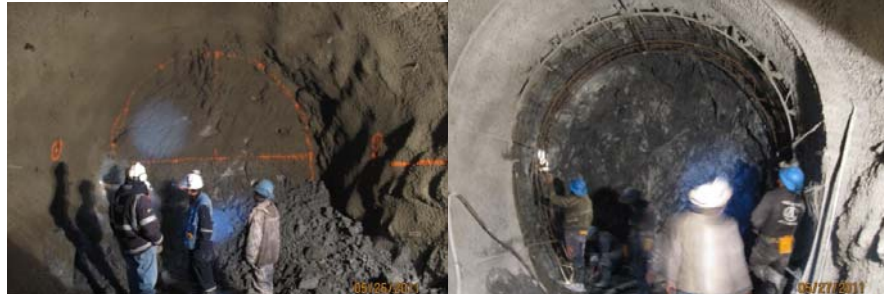
FOTO 25.- FRENTE DE TERRENO TIPO III. PROGRESIVA 0+070
