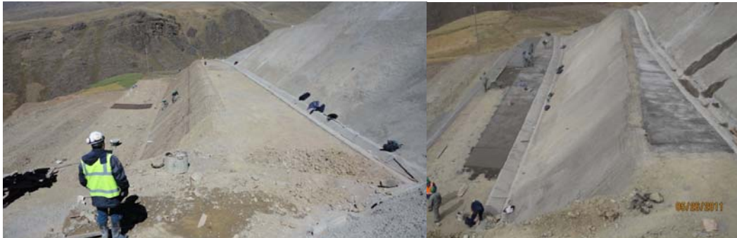
FOTO 29. TRATAMIENTO BANQUINAS, A) SECTOR SUR
