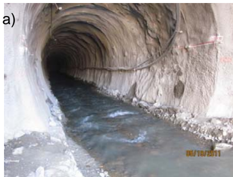
FOTO 31. DESVÍO DEL RÍO A TRAVÉS DEL TÚNEL
