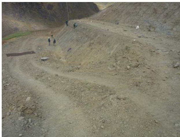
FOTO 38 TRATAMIENTO DE TALUDES SECTOR ESTRIBO IZQUIERDO
