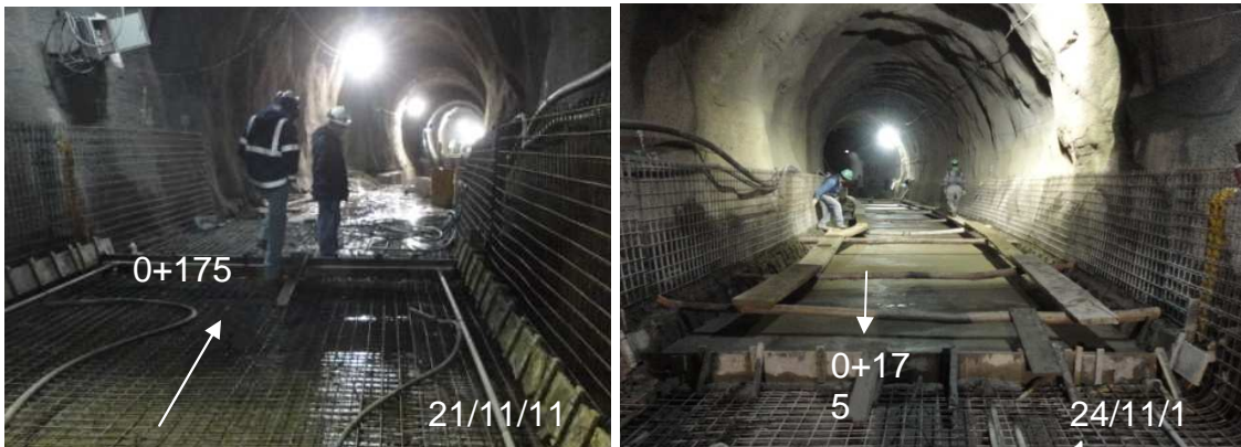
Foto N27a.- Malla instalada y vaciado de solera hasta la progresiva 0+175
