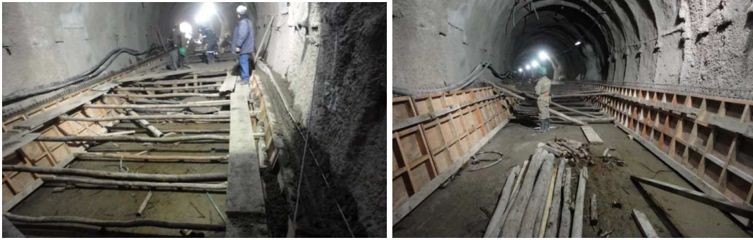
Foto N°30.- Encofrado y hormigonado de hastiales tramo 0+120 – 0+145
