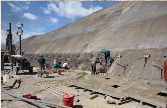
Foto N°14.- Perforación para drenes, encofrado y vaciado parcial de Pantalla.
