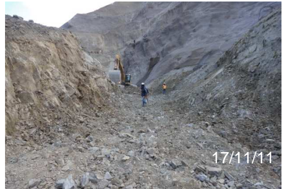
Foto N°18.- Retiro de material y regularización de Talud.
