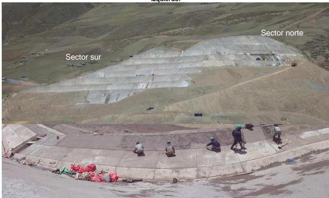
Foto N°10.- Banquetas Estribo Izquierdo.
