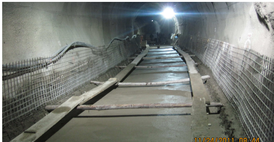
Foto N° 3 Replanteo Solera Túnel
