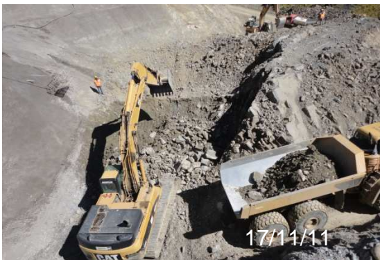
Foto N°18.- Retiro de material y regularización de Talud.
