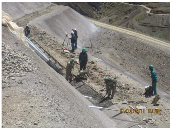
Foto N° 12.-Construcción de cunetas
