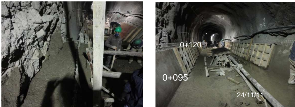
Foto N28.- Vaciado de hastiales de 0+075 a 0+095 y encofrado de 0+095 a 0+120
