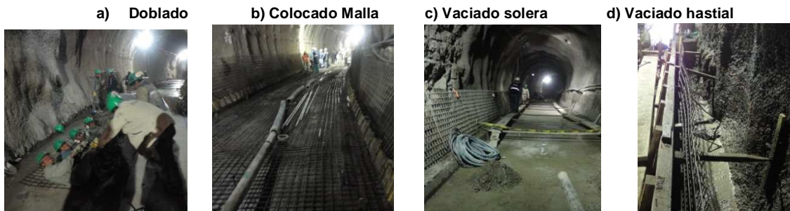
Foto N°27.- Secuencia de actividades en vaciado de solera
