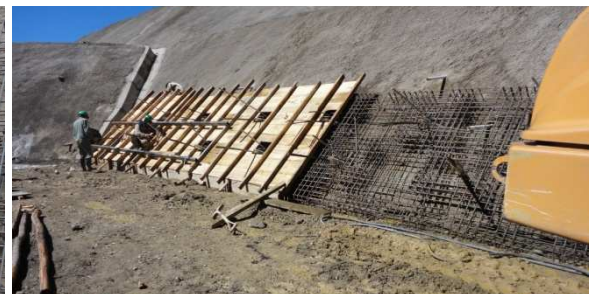
Foto N°14.- Perforación para drenes, encofrado y vaciado parcial de Pantalla.
