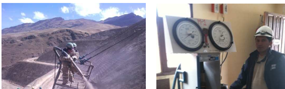
Foto Nº 8 Hormigón Proyectado y Ensayos en Laboratorio.
