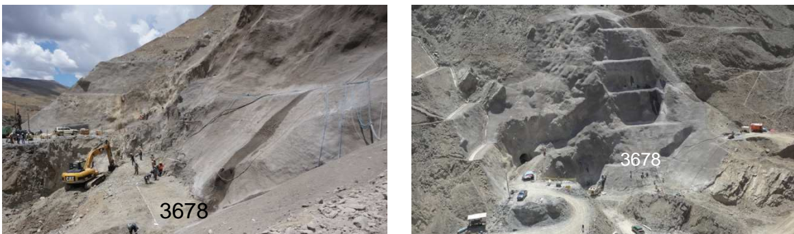
Foto N°16.- Perfilado y tratamiento de Talud por de bajo de la cota 3678
