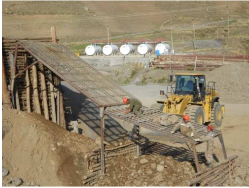
Foto N° 4 Ensayos e Instalación de Mallas 3D
