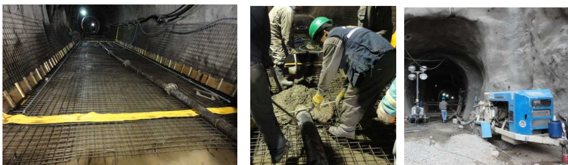
Foto N°25.- Primer tramo vaciado de solera (0+010 – 0+030)
