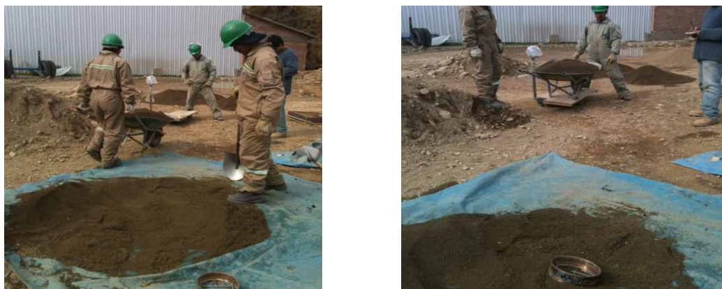
Foto N° 6 Ensayos de Laboratorio.
