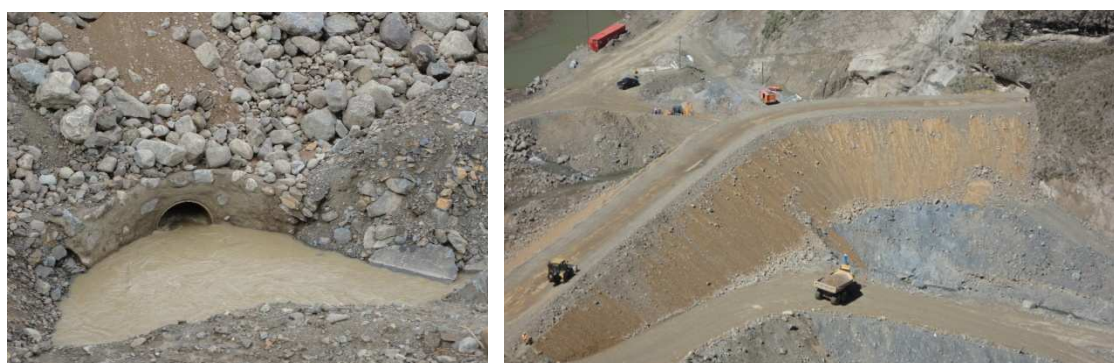
Foto N°33.- Ataguía y Tubería por donde circula el agua de los ríos Sivingani y Misicuni
