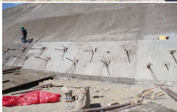
Foto N°14.- Perforación para drenes, encofrado y vaciado parcial de Pantalla.
