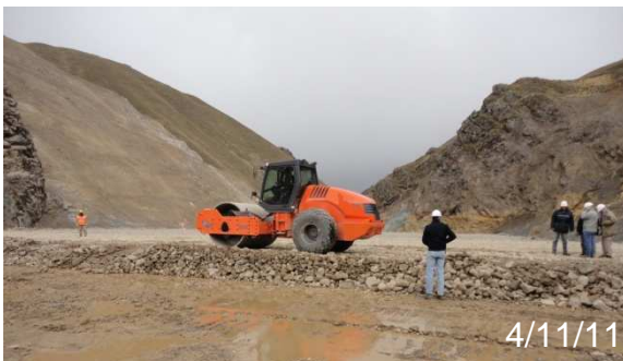
Foto N°35.- Relleno y compactado de materiales 3B y 3D
