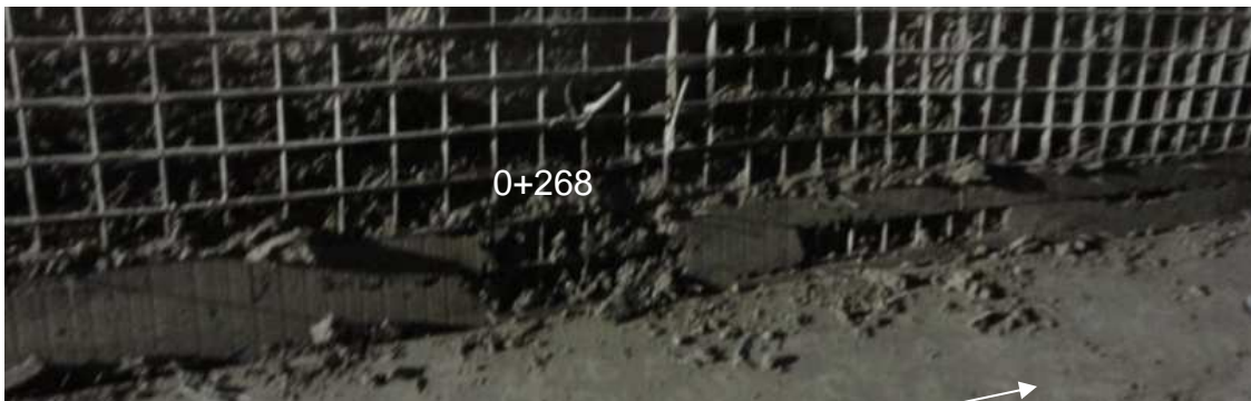
Foto N°31.- Hastial izquierdo, sin espacio para los 10 cm sobre la malla (0+268)
