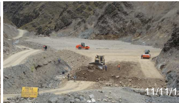
Foto N°35.- Relleno y compactado de materiales 3B y 3D
