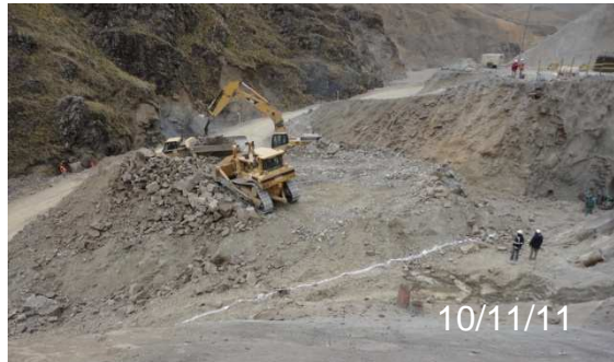
Foto N°17.- Voladura y retiro de material en el sector del Canal.
