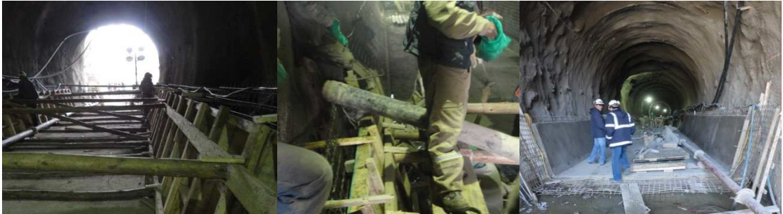
Foto N°26.- Encofrado, vaciado de 1er tramo de hastiales
