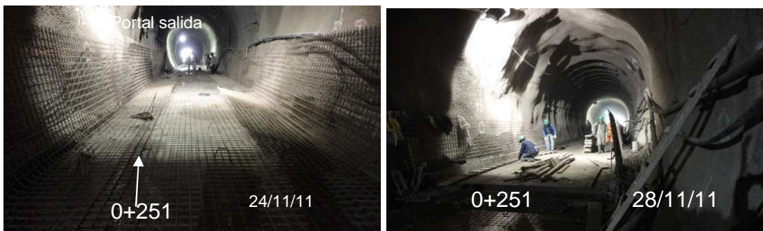
Foto N29.- Colocado de malla y vaciado desde la 0+ 251 hasta la 0+279
