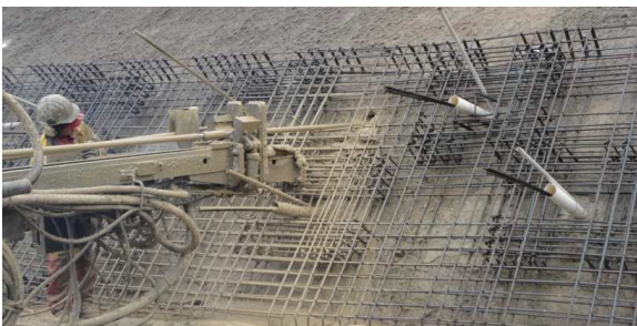
Foto N°14.- Perforación para drenes, encofrado y vaciado parcial de Pantalla.
