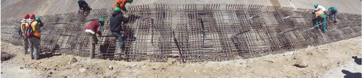
Foto N°13.- Armado de fierros y vaciado parcial de la Pantalla considerando los Drenes
