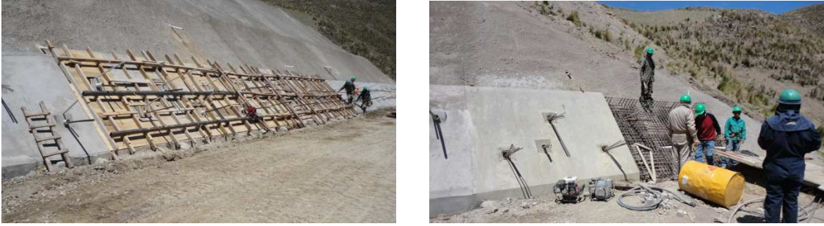
Foto N°15.- Encofrado y vaciado de sector central y armado de fierros en extremo norte
