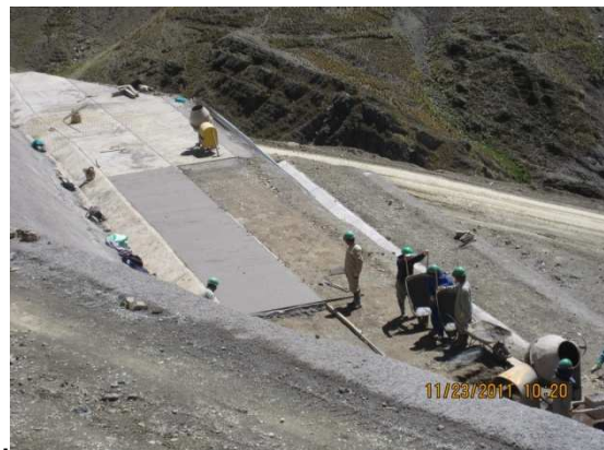
Foto N° 12.-Construcción de cunetas
