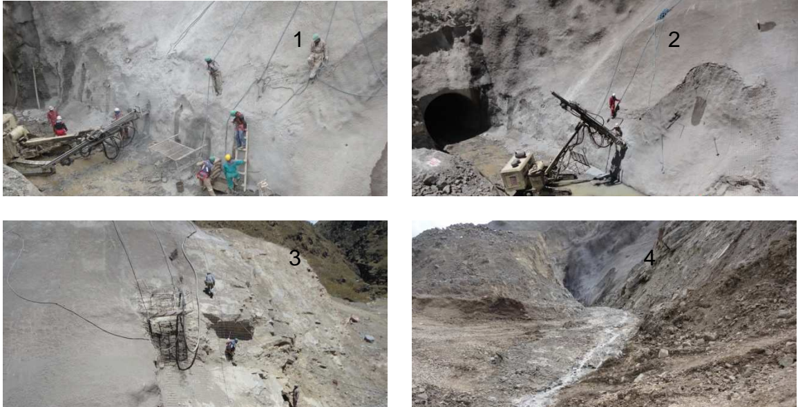
Foto N°22.- Perforación para pernos, retiro de bloques aflojados y flujo por gravedad.
