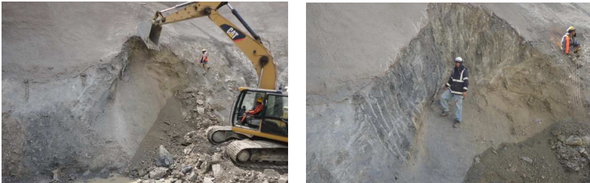
Foto N°21.- Regularización de sector de desprendimiento
