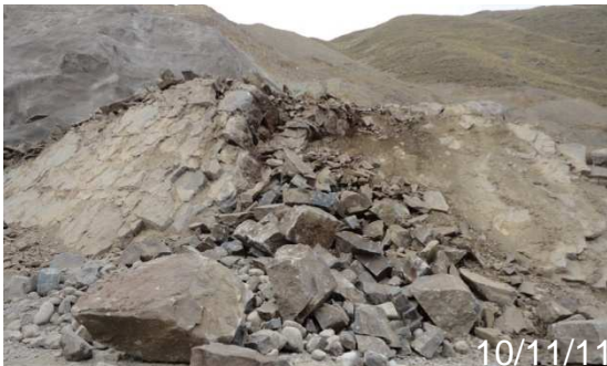
Foto N°17.- Voladura y retiro de material en el sector del Canal.
