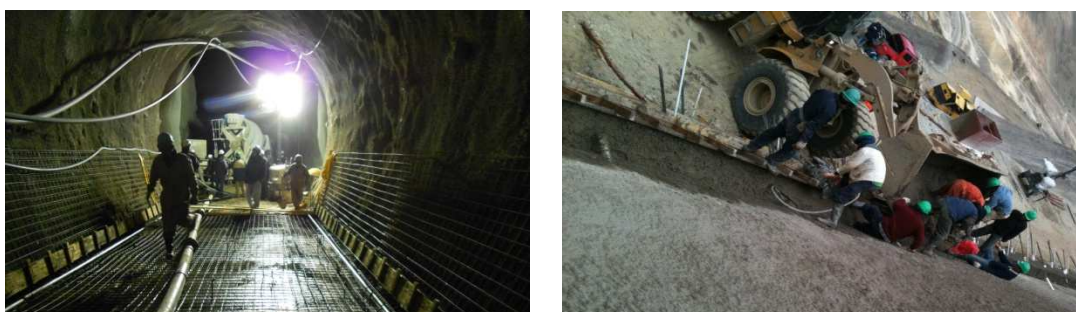
Foto N° 7 Control de Hormigones en sitio de obra.
