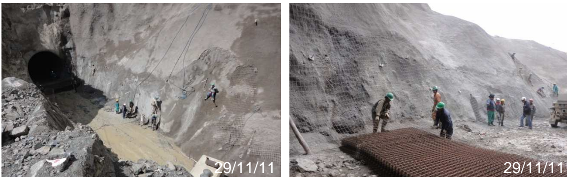
Foto N°23.- Tratamiento de pared izquierda de Canal
