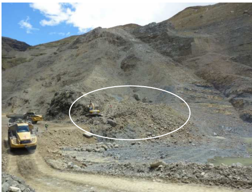
a) Aguas abajo Plinto Derecho
