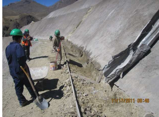
Foto N° 11.- Voladuras y construcción de cunetas
