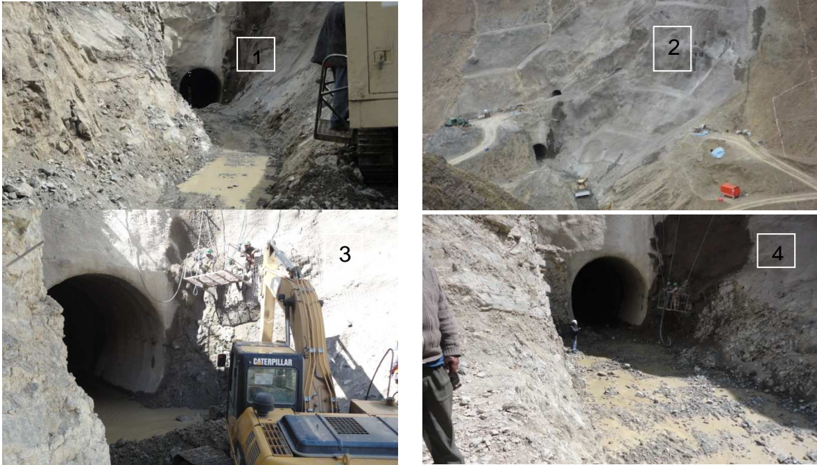
Foto N°20.- Excavación de Canal y tratamiento de Ta lud.
