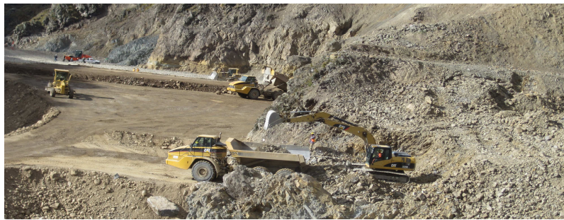
Foto N°35.- Relleno y compactado de materiales 3B y 3D
