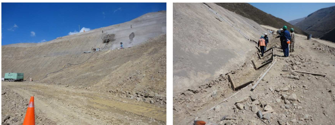
Foto N°23.- Aplicación de hormigón lanzado y construcción de cunetas
