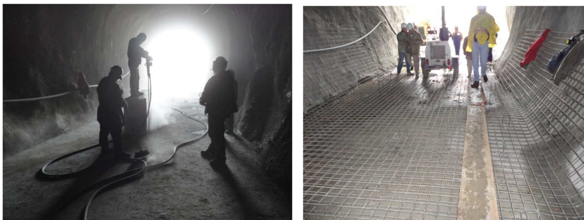
Foto N°19.- Perforación, instalación de anclajes y malla electro soldada
