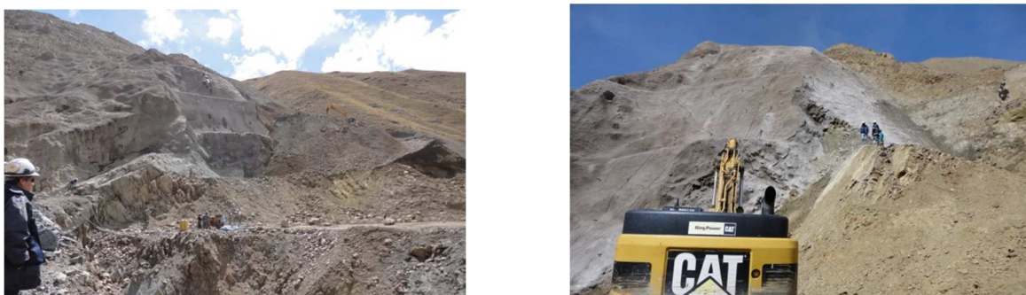
Foto N°29.- Corte hasta 3680 y afloramiento rocoso
