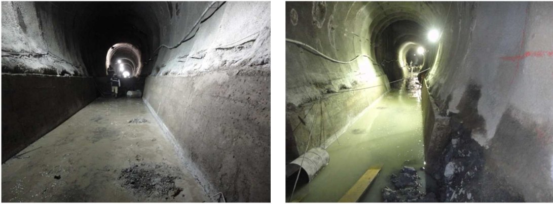
Foto N°16.- Muro en los hastiales como base de las cerchas instaladas
