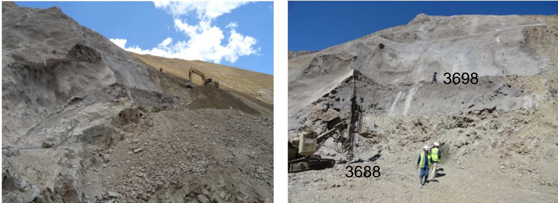
Foto N°25.- Retiro de material suelto y corte de Talud hasta la 3688
