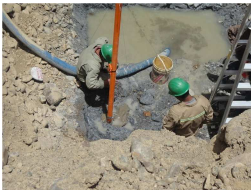
Foto N° 42 Placa de asentamiento 1 en el medidor MM-3
