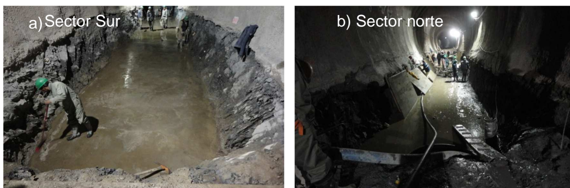
Foto N°14.- Vaciado de pre solera en sector de bypass
