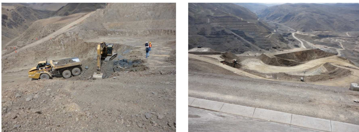
Foto N°34.- Excavación de Vertedero hasta la cota 3 771
