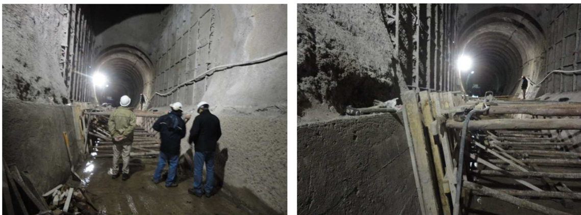
Foto N°18.- Armado de encofrado y vaciado de hastiales en Cámara de Válvulas
