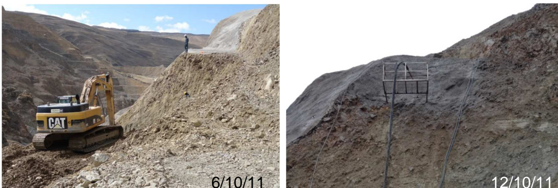
Foto N°27.- Perfilado y Tratamiento del Talud desde la cota 3718
