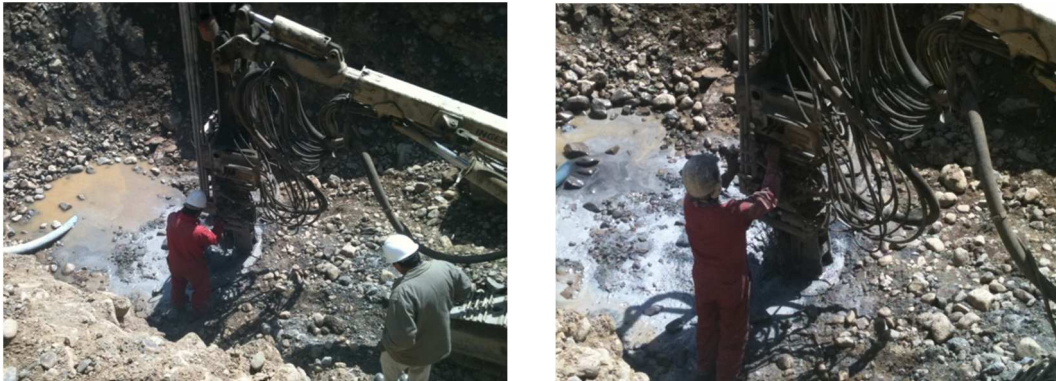
Foto N°36 Perforación de pozos con un diámetro de 4”
