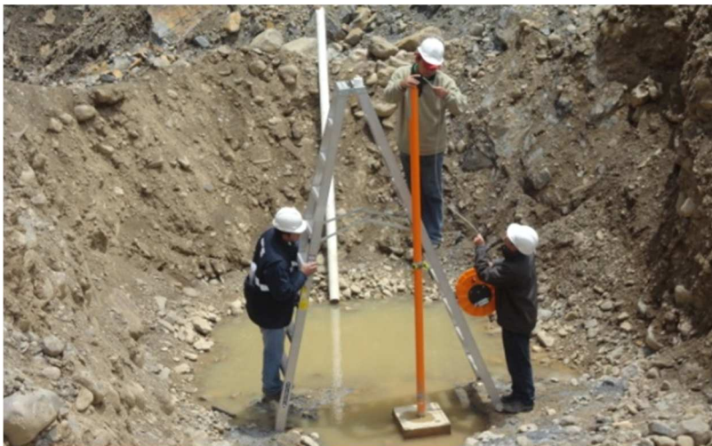
Foto N° 47 Medición Conjunta CHM-EC
