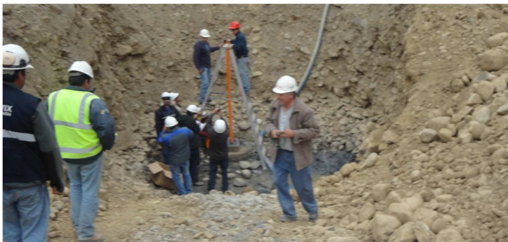
Foto N° 46 Capacitación en Obra
