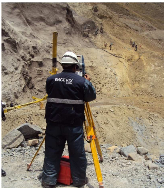
Foto N° 3 Replanteo Presa
