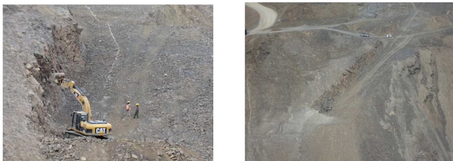
Foto N°22.- Limpieza y estado actual del Plinto
