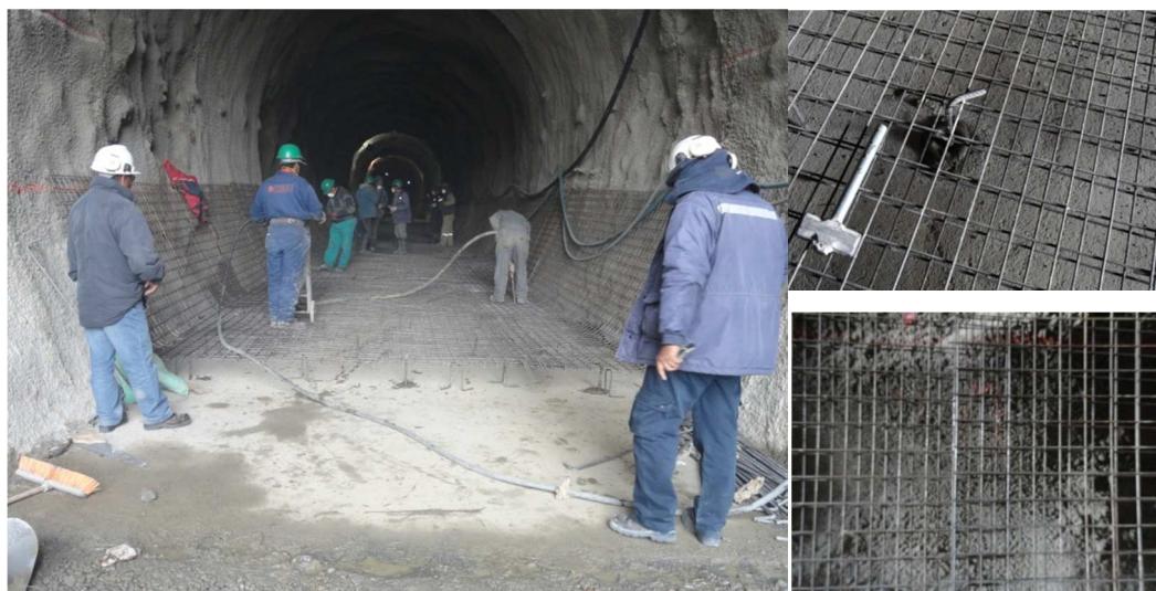
Foto N°32 Inyecciones para los Tirantes Tensionados.
