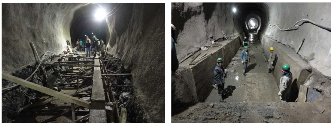
Foto N°15.- Encofrado y vaciado de hastiales
