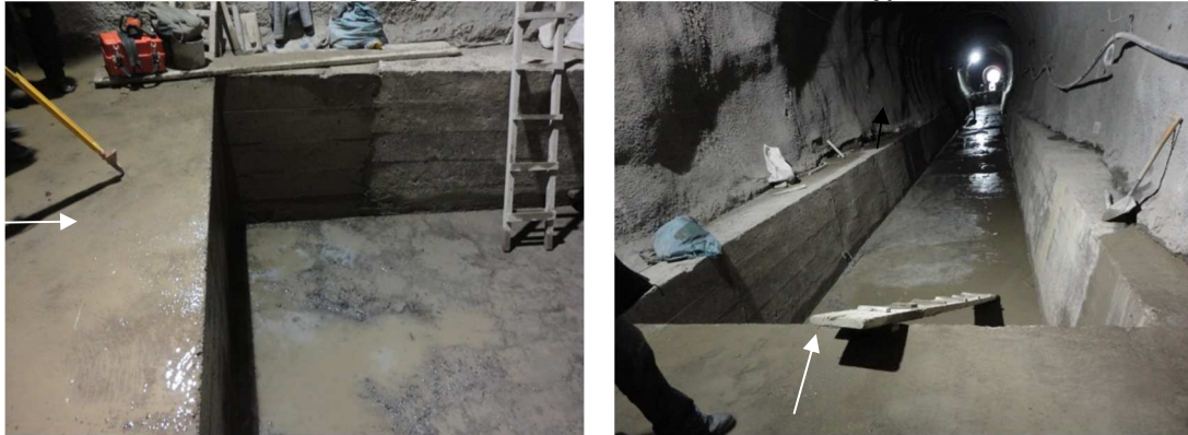
Foto N°17.- Regularización del vaciado en el sector del bypass
