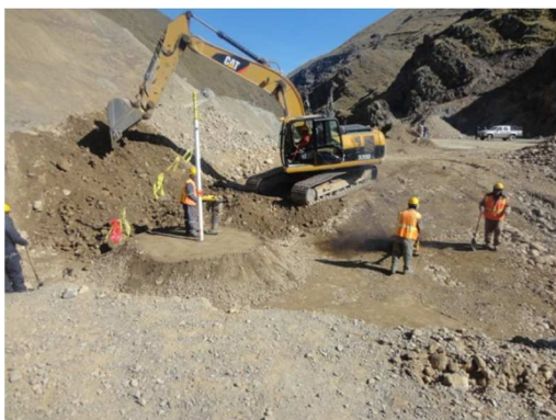
Foto N° 43 Relleno adyacente a los Instrumentos.
