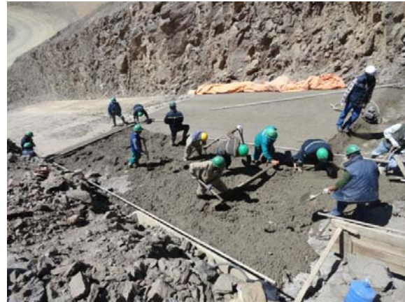
EXCAVACION PARA TRATAMIENTO VERTICAL EN FALLAVACIADO DE Ho DENTAL
