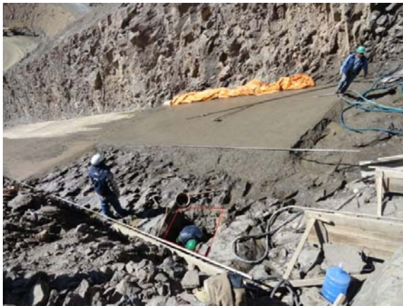
EXCAVACION PARA TRATAMIENTO VERTICAL EN FALLAVACIADO DE Ho DENTAL
