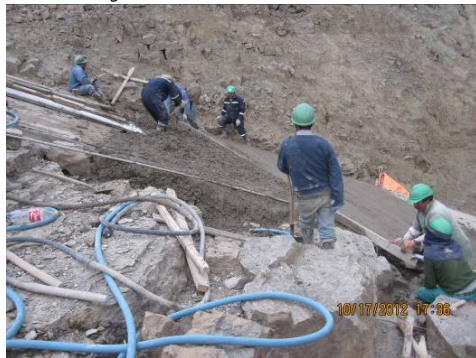
Foto 5: Hormigonado de tramo liberado
