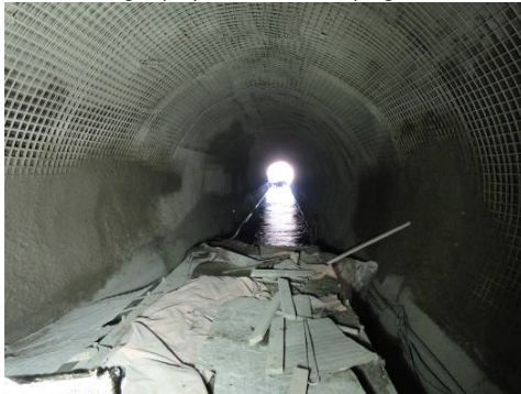
Foto 5: Instalación malla electrosoldada prog. 0+100
