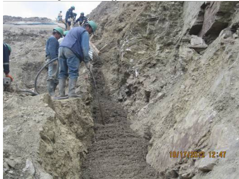
Foto 5: Hormigonado de tramo liberado
