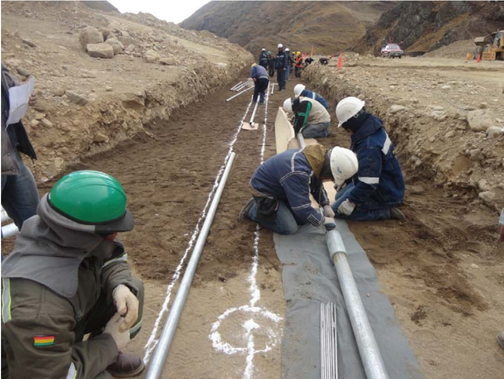
Instalación de línea 3705 de celdas de Asentamiento HV
