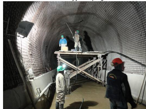
Foto 6: Instalación barras de fijación prog. 0+090
