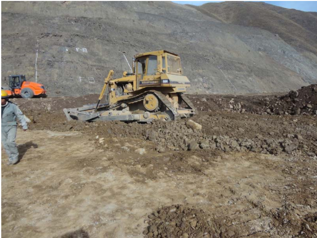
Tendido material Presa
