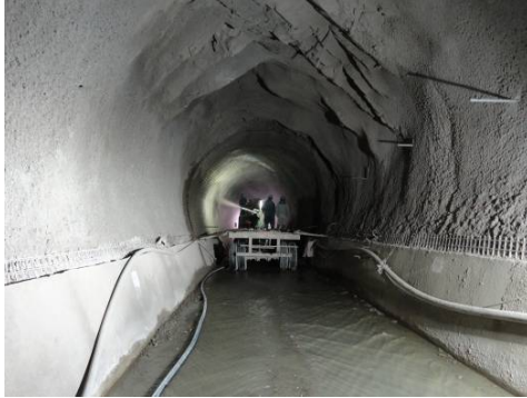
Foto 3: Hormigón proyectado hastiales prog. 0+095
