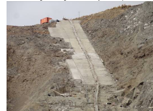
Foto 6: Hormigón de regularización ejecutado plinto derecho
