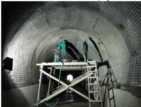
Foto 5: Instalación malla electrosoldada prog. 0+100
