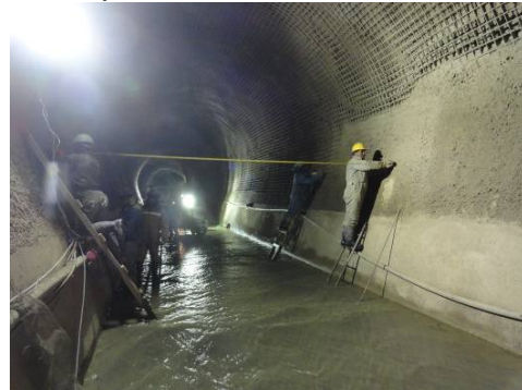
Foto 6: Instalación barras de fijación prog. 0+090
