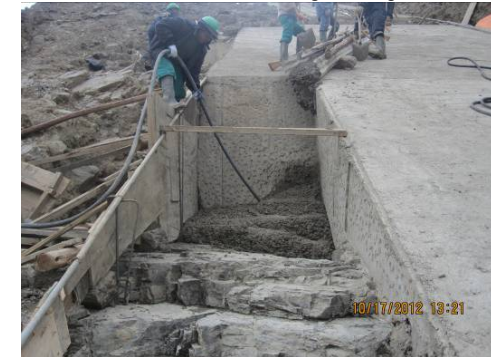
Foto 6: Hormigón de regularización ejecutado plinto derecho
