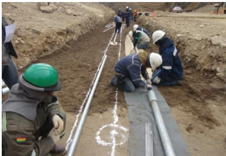
Instalación Extensómetro Múltiple Horizontal instalada en la cota 3705.00
