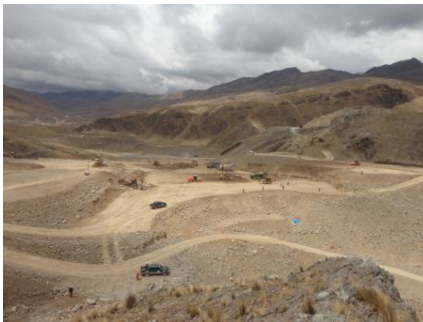
Incorporación de materiales en Presa.
