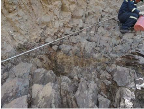
EXCAVACION VERTICAL EN FALLA
