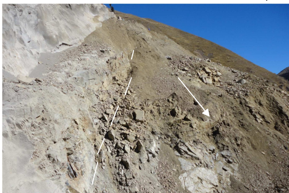
Foto N°30.- Talud hacia el Canal, sin tratamiento, sufrió cierto asentamiento
