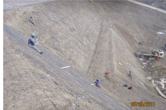
Foto Nº 21 Tratamiento de taludes Cortina atirantada
