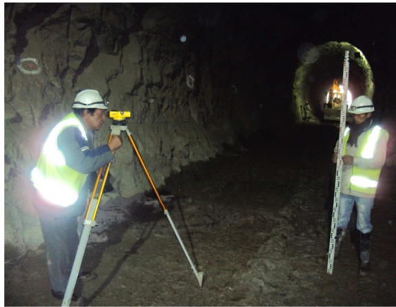
Foto N° 3 Túnel Verificaciones de Niveles
