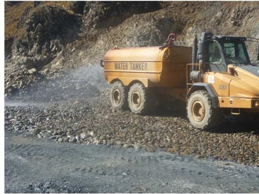
Foto Nº 41 Relleno Humectación del material.
