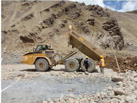
Foto N° 40 Relleno de la presa.
