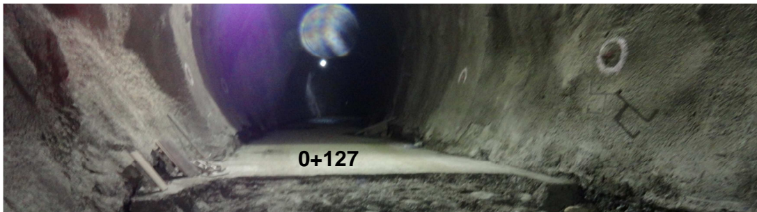
Foto N°16.- Vaciado hasta la progresiva 0+127
