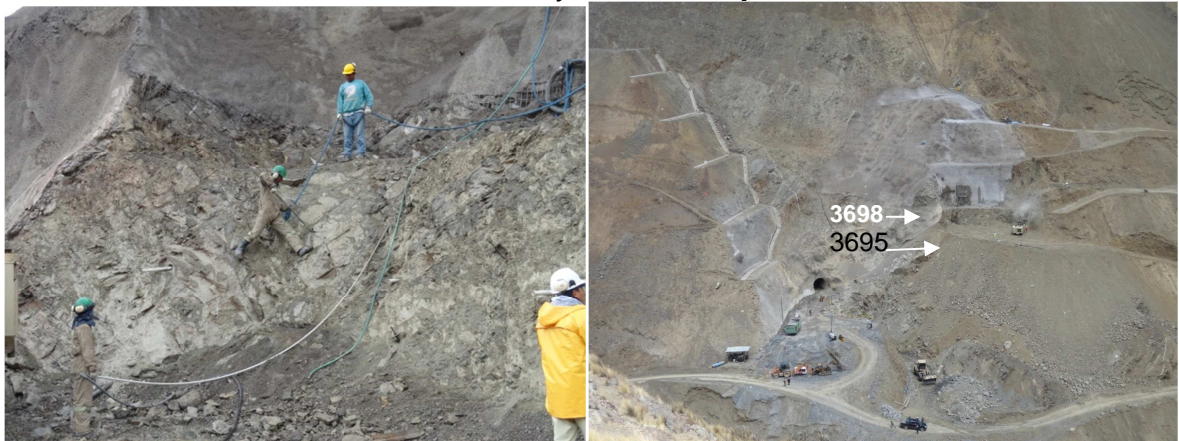
Foto N°34.- Instalación de drenes y Pernos de anclaje en Talud 3698-3695.
