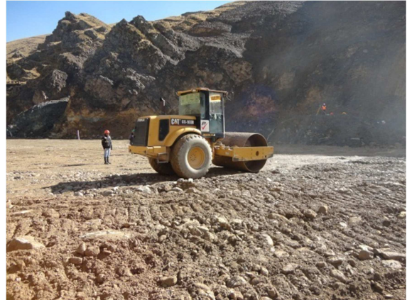
Foto N° 40 Relleno de la presa.
