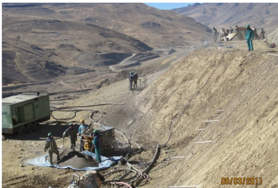
Foto Nº 21 Tratamiento de taludes Cortina atirantada
