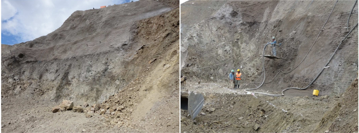
Foto N°33.- Se inicia excavación hasta la cota 3695
