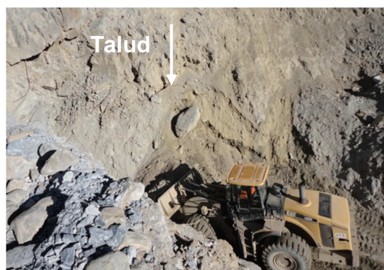
Foto N°29.- Excavación de pie de Talud de Portal de salida
