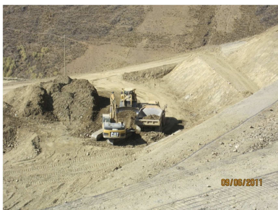
Foto N° 19 Excavación en Banquinas.
