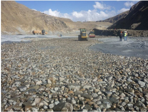
Foto Nº 41 Relleno Humectación del material.
