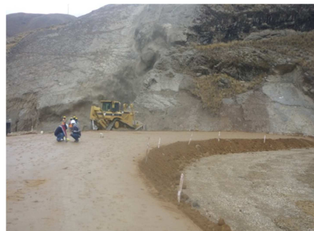
Foto N° 5 Toma de densidades, Relleno de material sector Ataguía (1-A).
