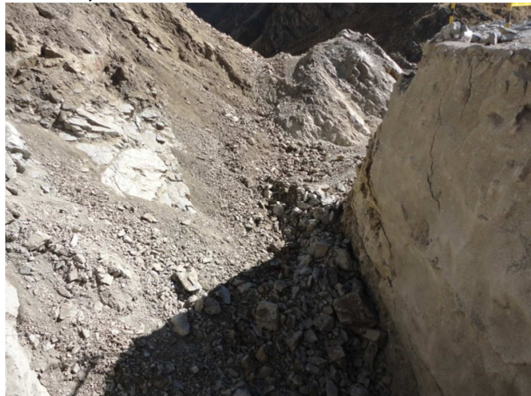
Foto N°30.- Talud hacia el Canal, sin tratamiento, sufrió cierto asentamiento
