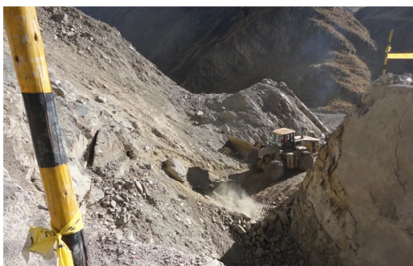
Foto N°29.- Excavación de pie de Talud de Portal de salida
