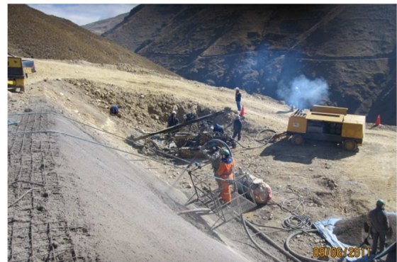
Foto Nº 21 Tratamiento de taludes Cortina atirantada
