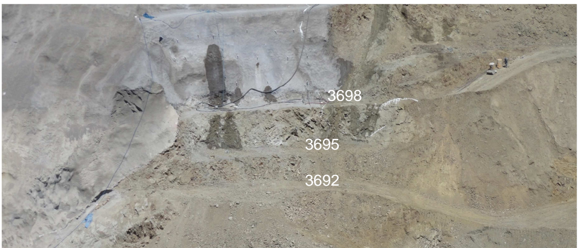
Foto N°35.- Excavación hasta la cota aproximada de 3692.
