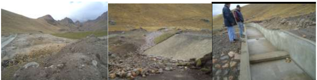
REPOSICIÓN DE VERTIENTES AFECTADAS: PROYECTO LAGUNA ISKAY COHA
