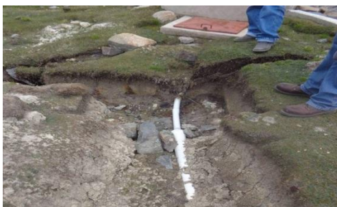
Obra de toma instalación 300 m de extensión tubo de 3"
