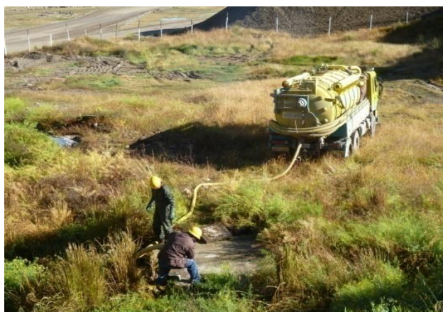
Limpieza cámara séptica
