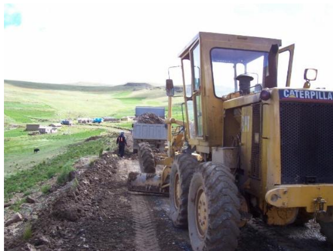
Equipo realizando trabajos en Rio Verde
