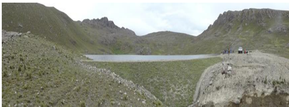
Vista general de la represa de Socara
