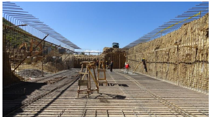
Proceso de construcción de las estructuras
