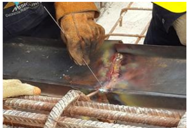
Soldadura de junta de cobre
