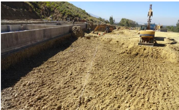
Excavaciones para fundar las estructuras
