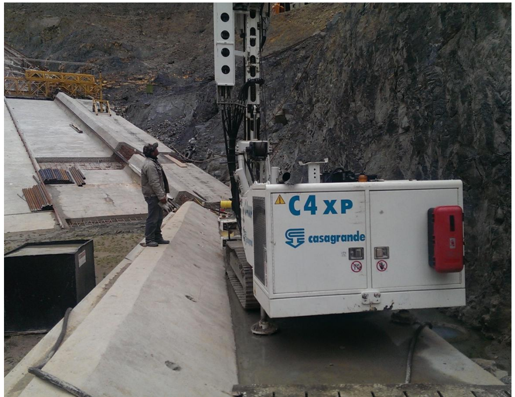
Equipo de Perforación
