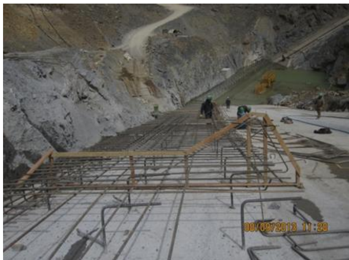
Barras de anclaje y acero de refuerzo Grado 60
