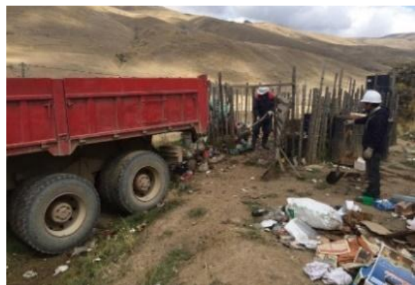
Traslado de residuos después de realizar limpieza – Contratista CAMCE
