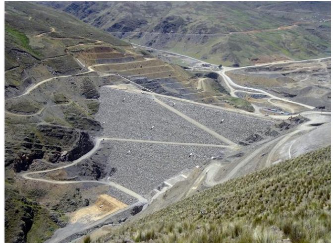
Cara de Enrocado noviembre 2013
