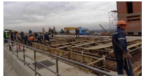
Obreros trabajando en la construcción de la Planta de Tratamiento
