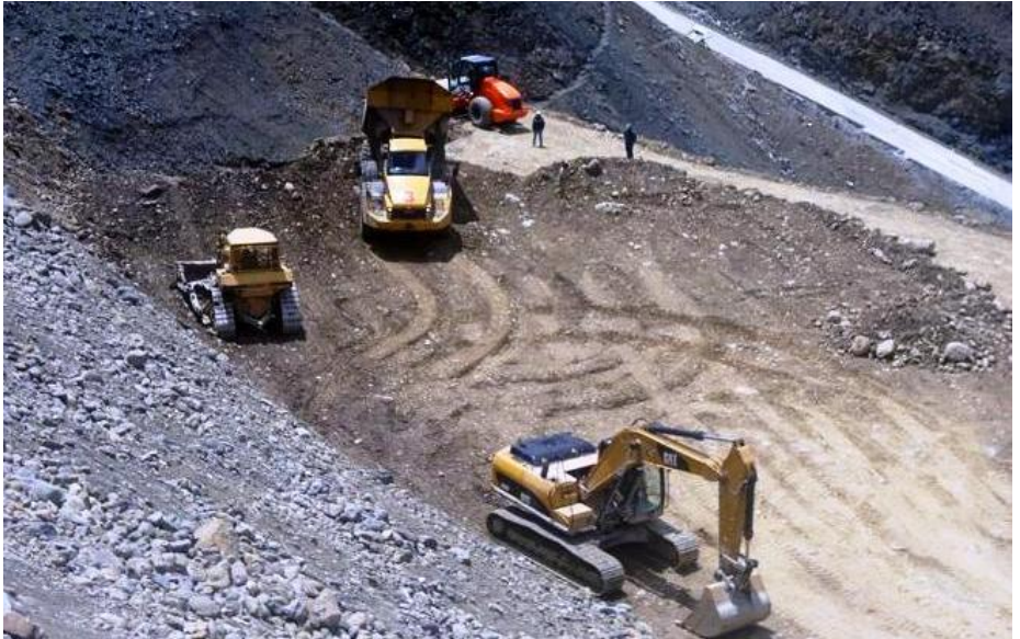
Maquinaria operando en la Construcción de la Presa – Estribo Izquierdo
