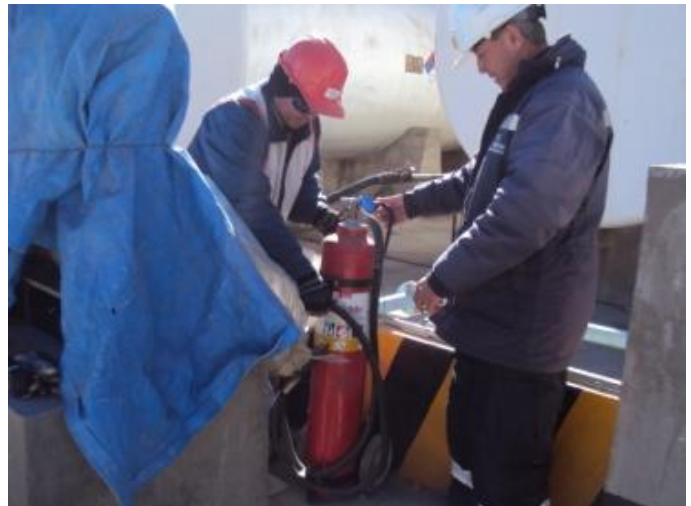
Trabajadores realizando el control de extintores
