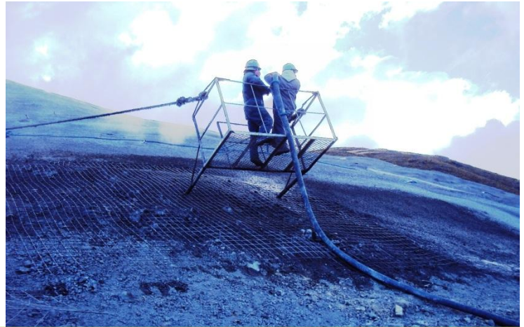
Trabajadores utilizando equipo y accesorios de protección personal
