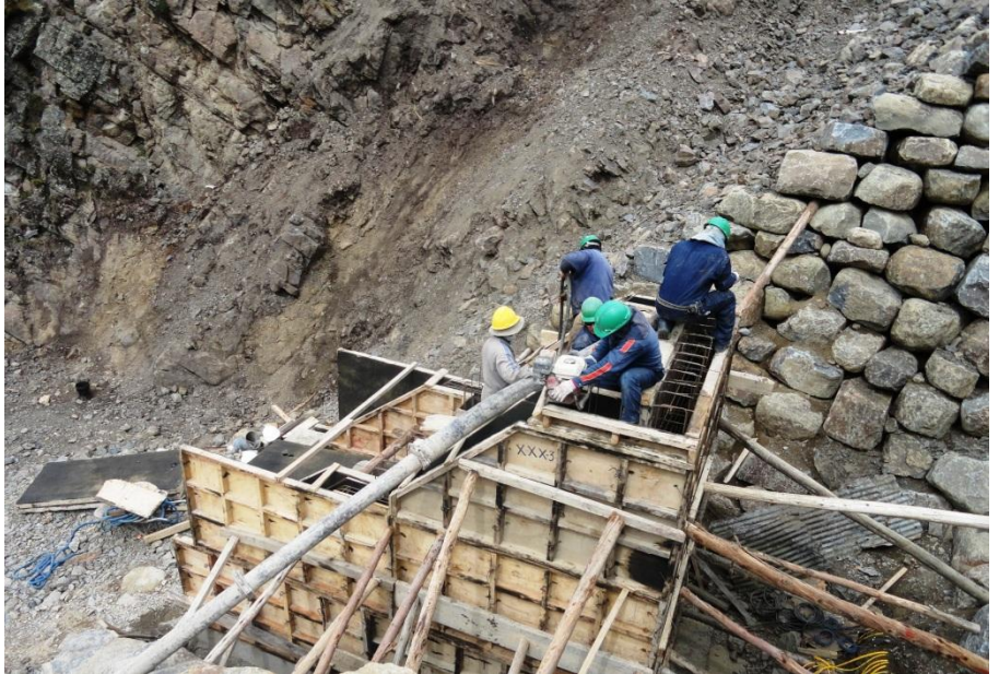
Construcción de obras en la Presa de Misicuni
