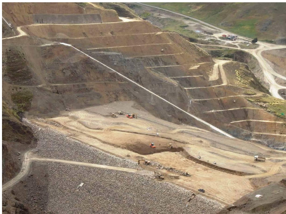
Avances de la Construcción de la Presa mes de marzo 2013
