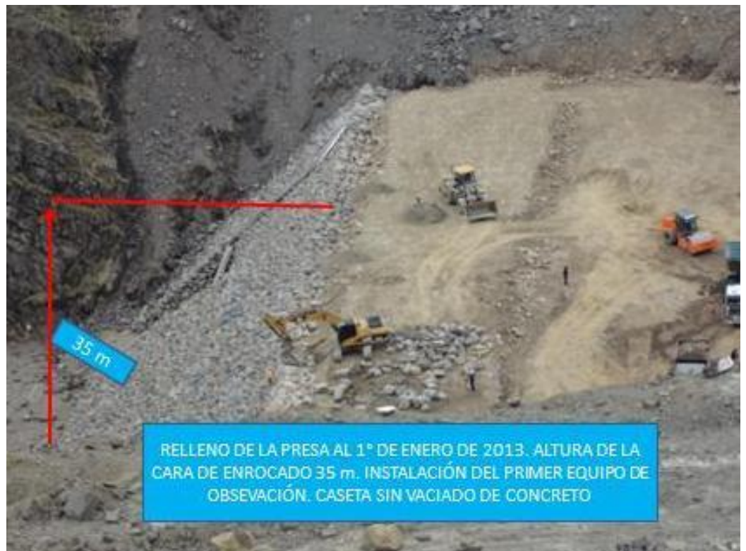
Relleno de la presa al 1 de enero de 2013
