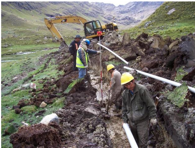
Cambio de tubería a 3"
