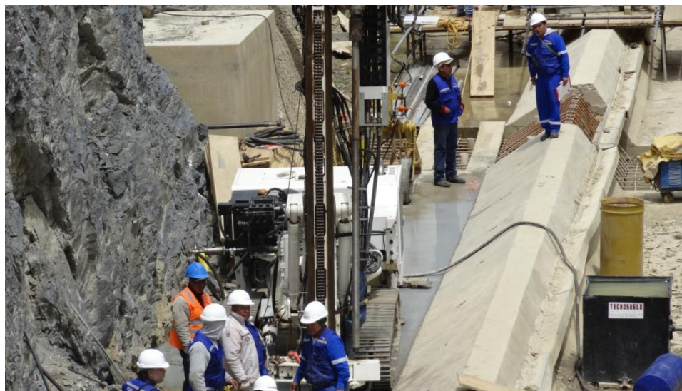
Empresa Tecnosuelo realizando trabajos de perforado e inyecciones
