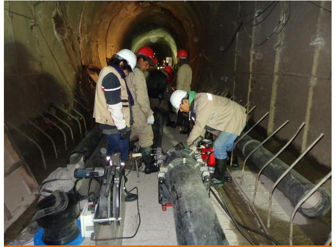
Soldado de tubería HDPE zona cámara de válvulas galería
