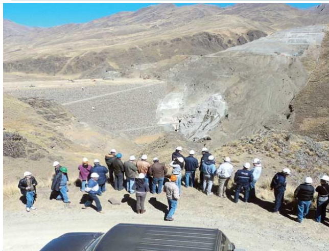
Inspección al avance de obras
