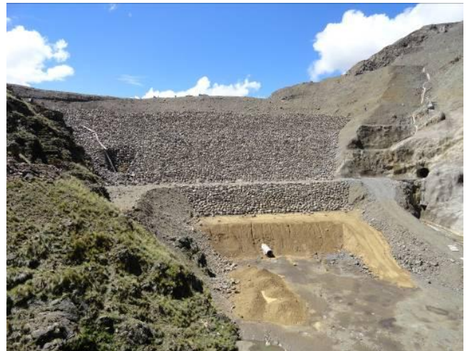
Vista panorámica del ingreso a la galería de acceso
