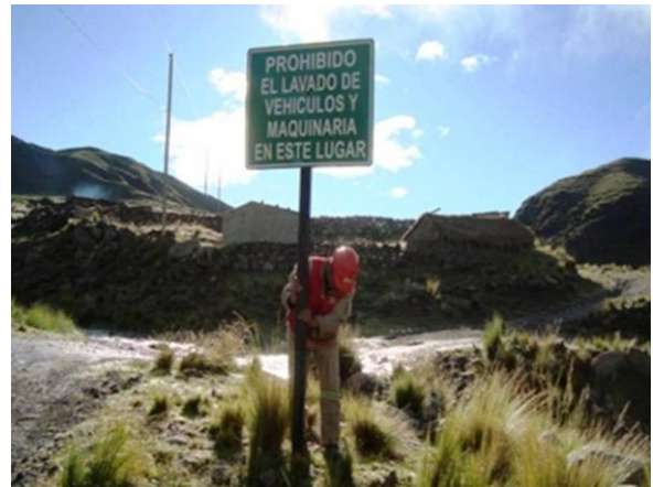
Instalación de uno de los letreros informativos
