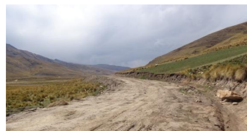
Camino Perimetral progresiva 0+100 km.
