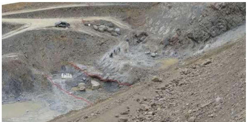
Vista de la zona de la falla
