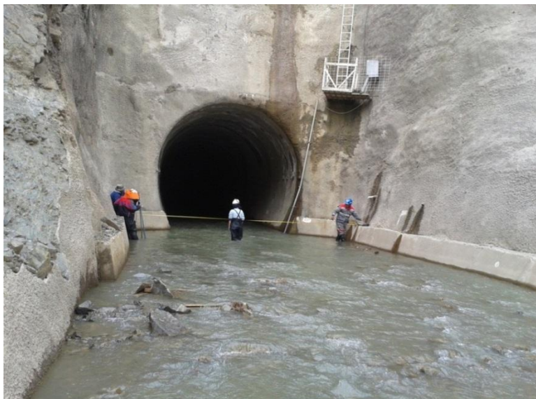
Aforo sobre el túnel de desvío
