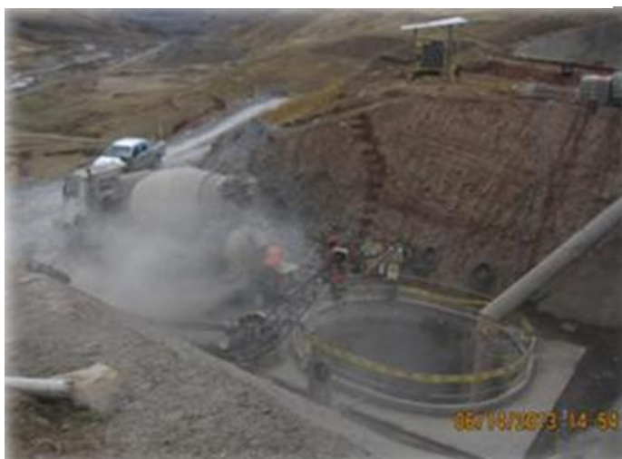
Hormigón proyectado vía seca con fibra
