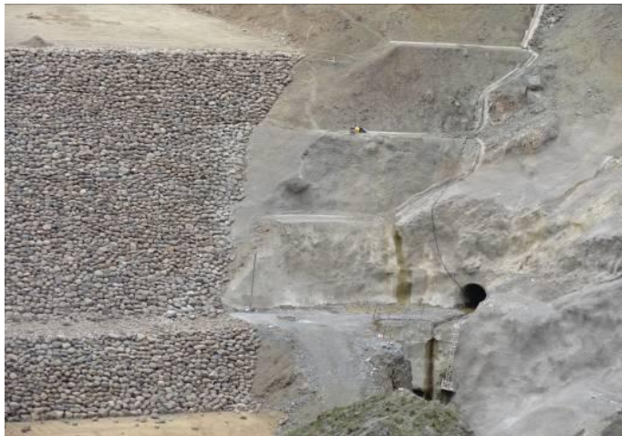
Ingreso a la galería de acceso
