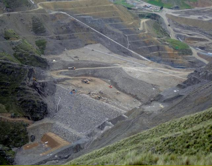
CARA DE ENROCADO (Vista a enero de 2013)
