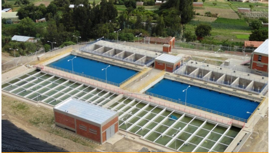
Panorámica de las Unidades de Tratamiento
