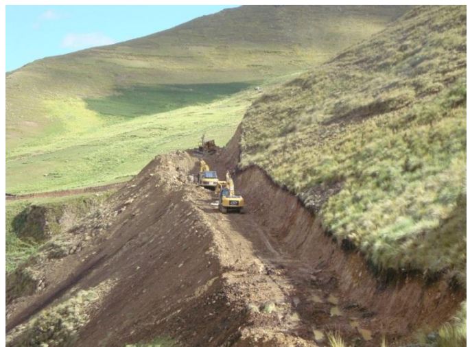
Excavacion de camino 0+960 -1+200.
