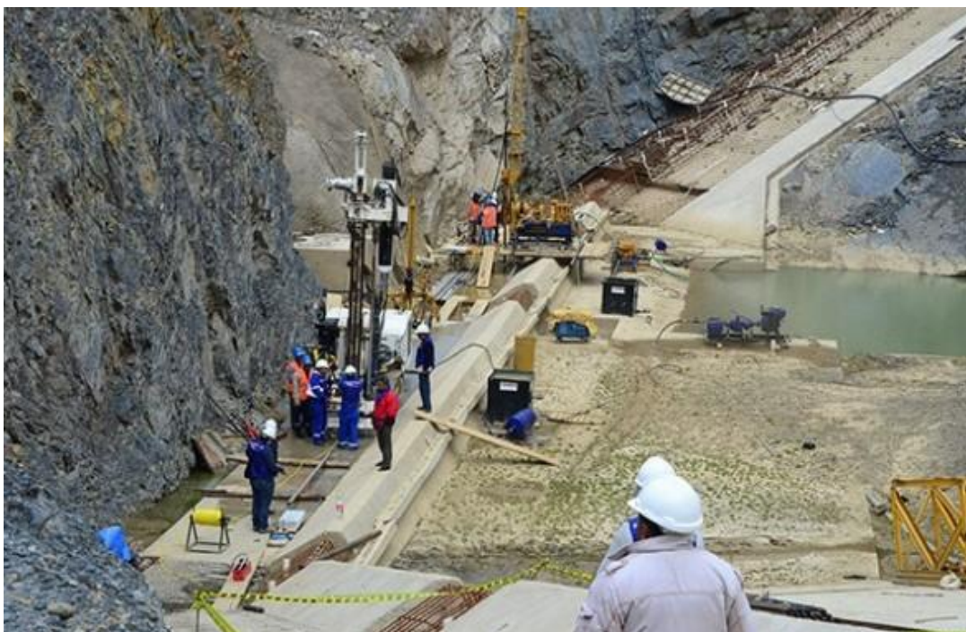
Reinicio de obras en la Presa Misicuni
