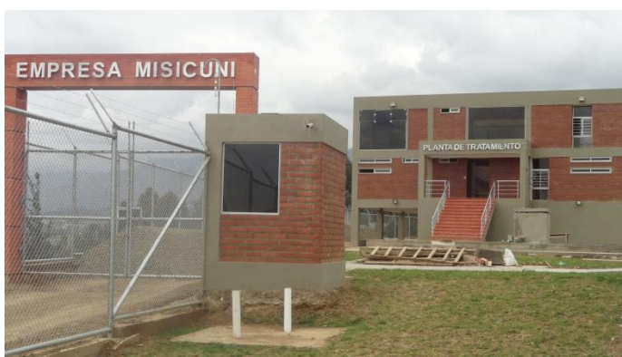
Ingreso a las instalaciones de la Planta de Tratamiento
