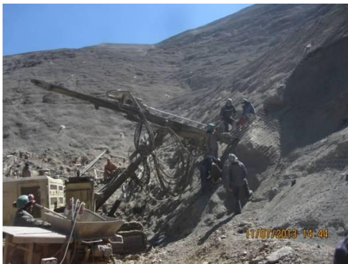
Colocado de pernos tipo A1 en el talud
