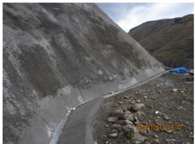
Hormigonado de cuneta en banquina
