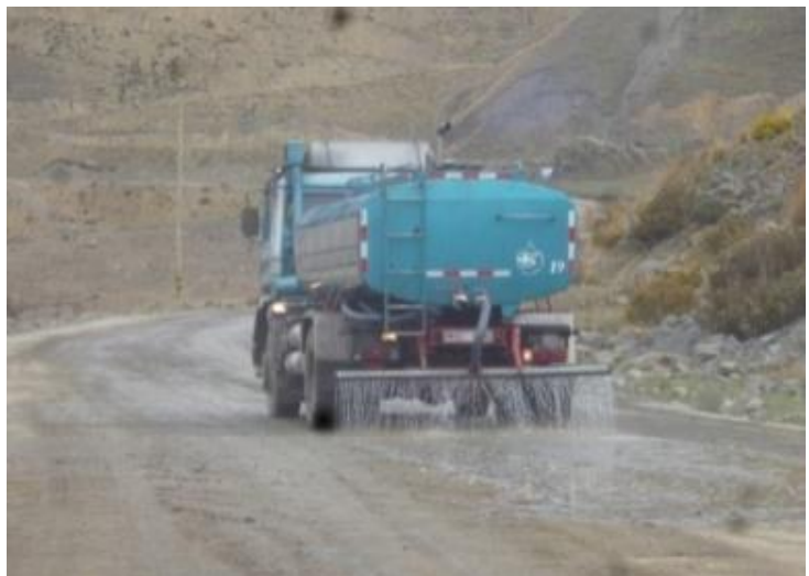
Carro cisterna realizando humectación para el control de la emisión de polvo
