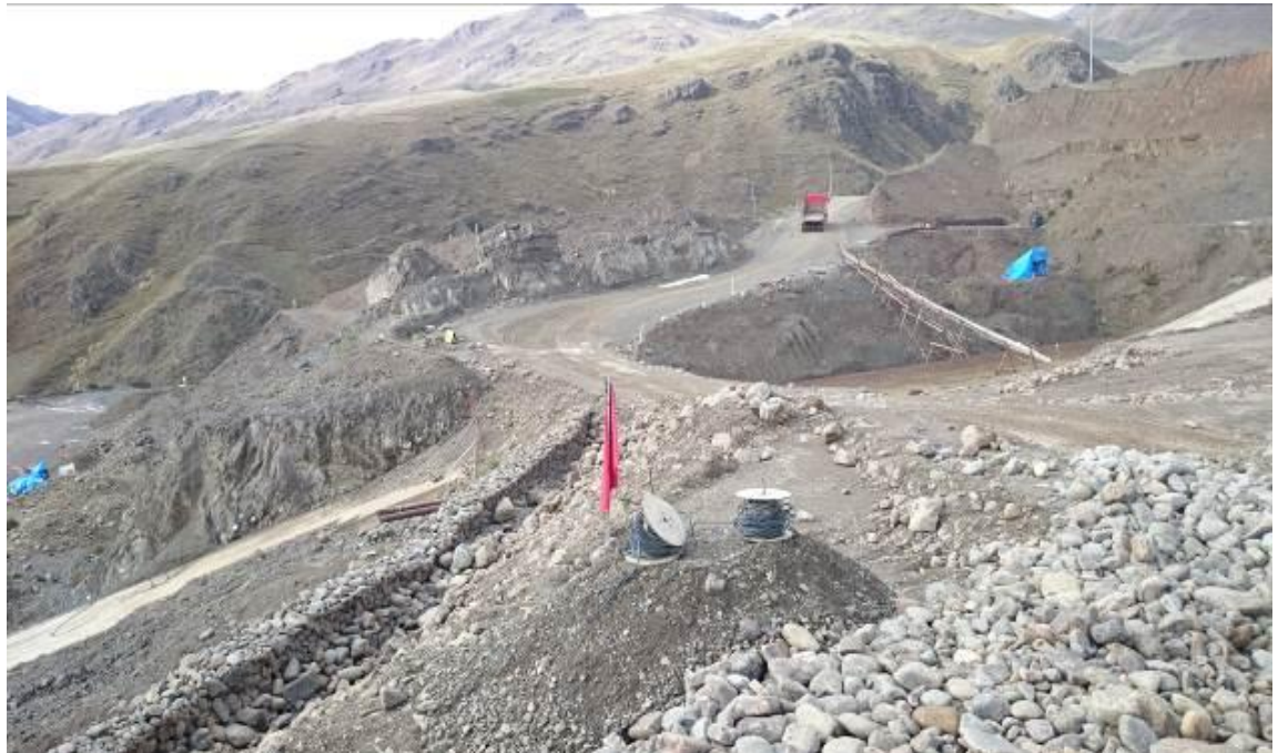
Relleno de material 3C y 3D
