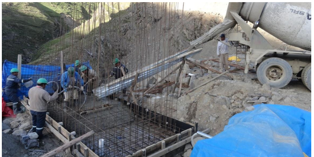
Ejecución de Hormigonado
