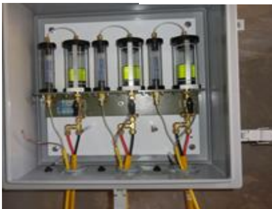
Cables de instrumentos instalados
