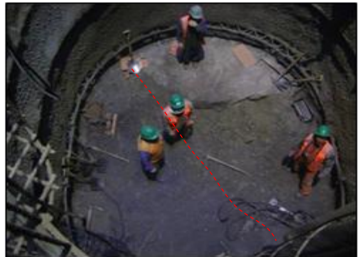
Instalación de Cerchas y hormigón lanzado a lo largo de la columna del pozo.
