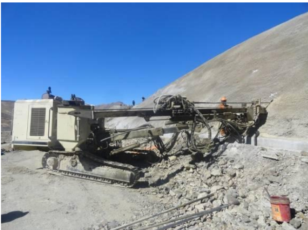
Colocado de Drenes Horizontales Profundos
