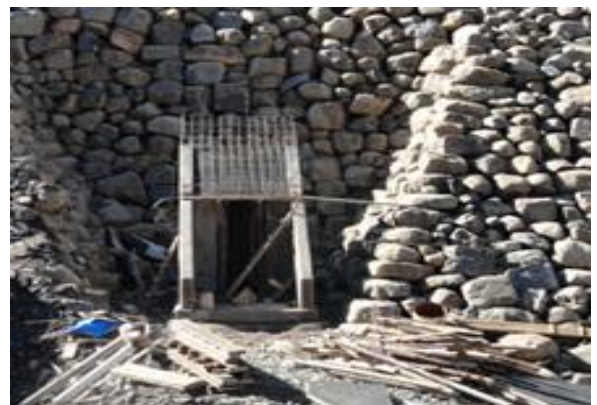
Construcción de casetas
