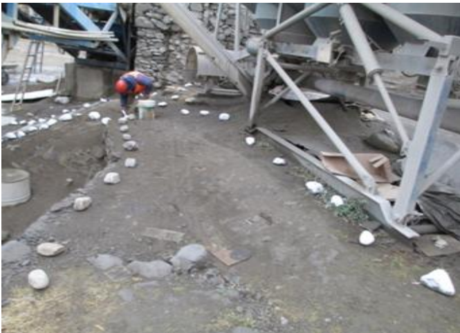
Trabajador señalando la ruta para orientar el tráfico
