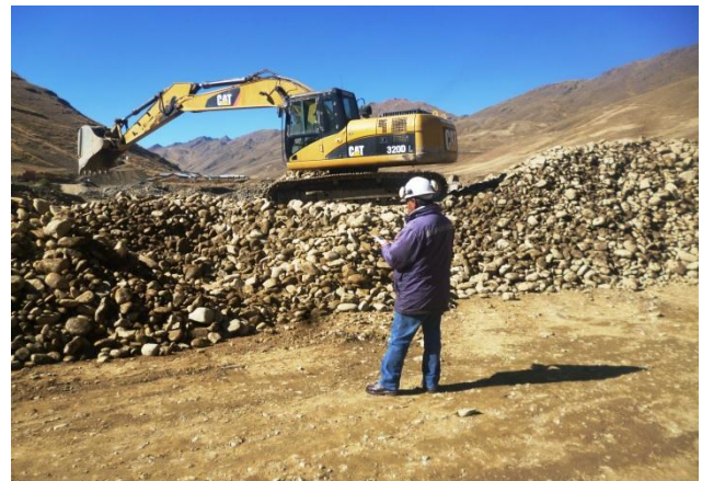
Personal especializado realizando control de emisión de ruido
