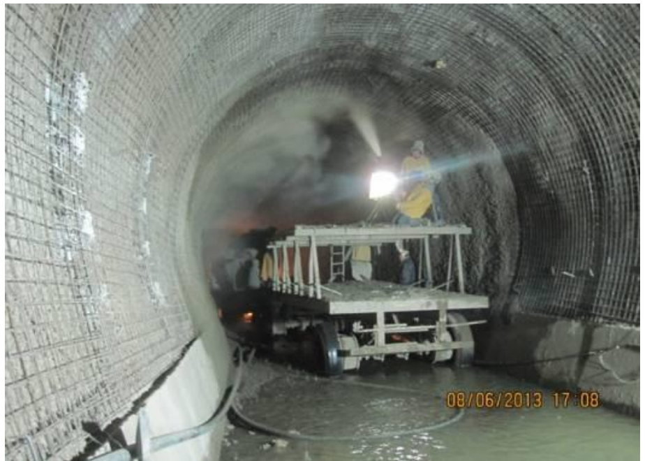
Hormigón proyectado
