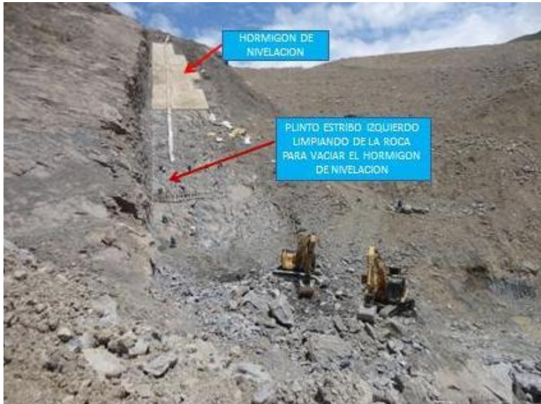
Ejecución actividades Plinto lado Izquierdo
