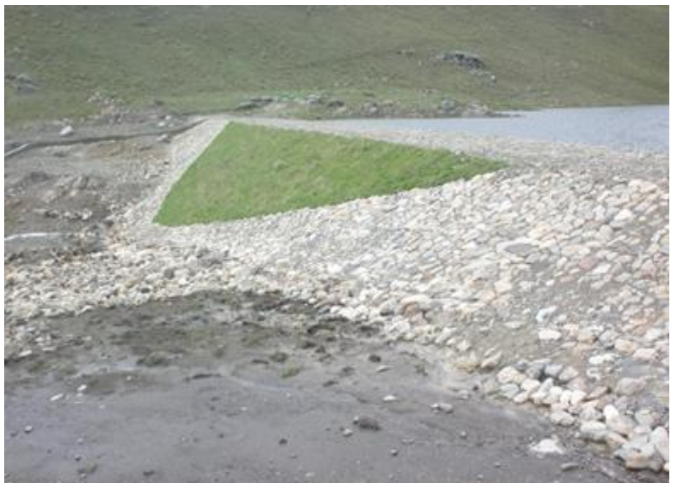
Vista general de la represa de Iskay Khocha
