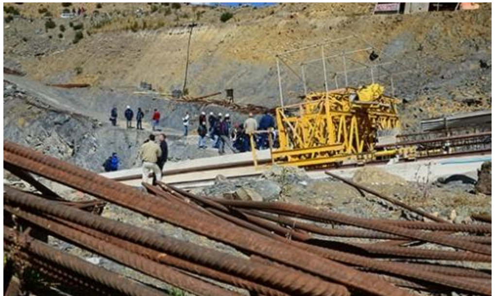
Obras de la represa Misicuni paralizadas
