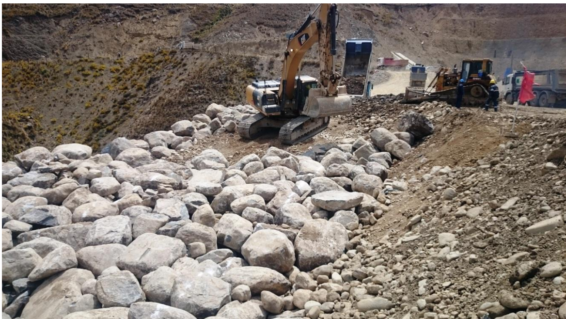
Relleno de material 4
