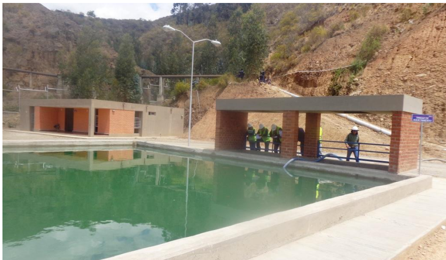
Tanque de aquietamiento
