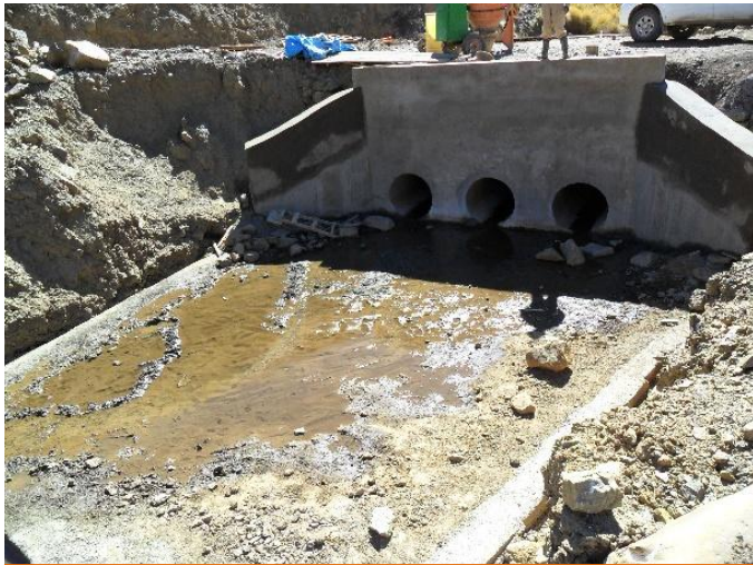
Mampostería de piedra de Disipadores. Alcantarilla 2+600
