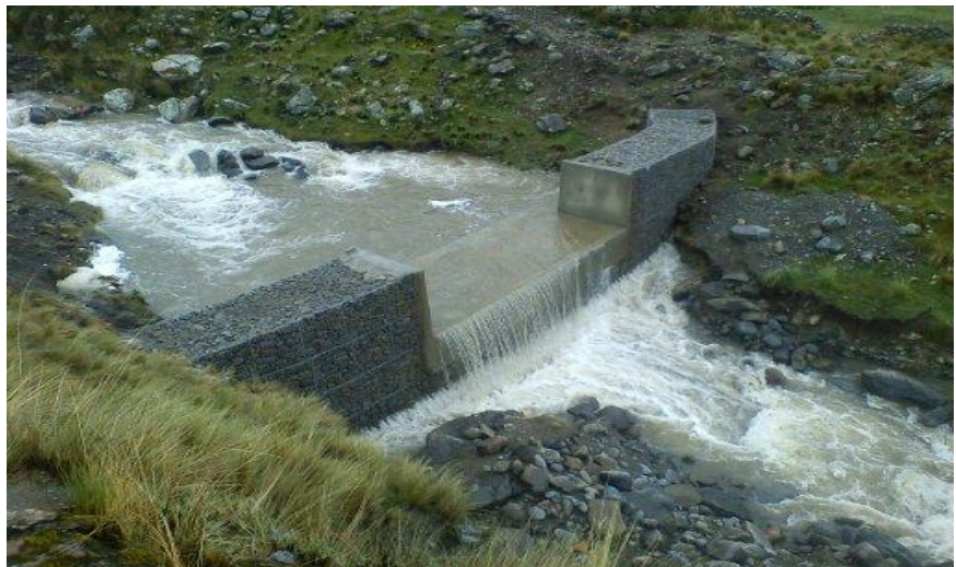
Dique de consolidación en la quebrada Sivingani II
