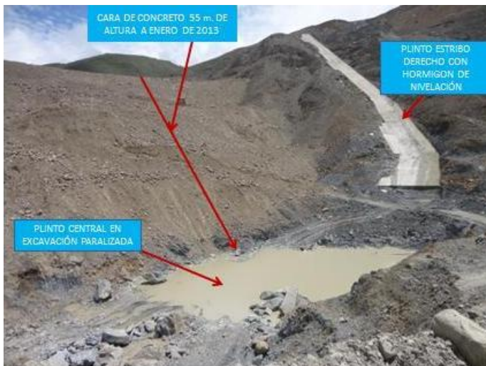
Ejecución actividades Plinto Central
