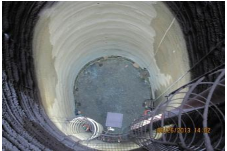
Terreno alterado milonitizado y roca fracturada a muy fracturada.
