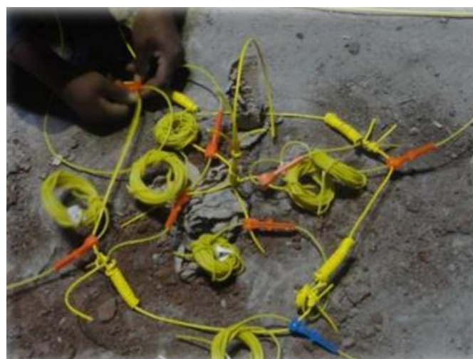
Excavación por voladura entre cotas 3727.20 a 3722.60
