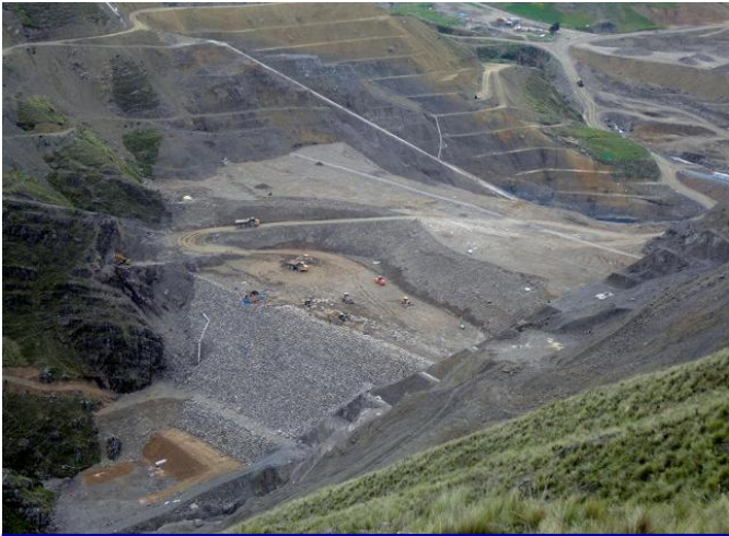
Cara de Enrocado y Relleno, finales 2012
