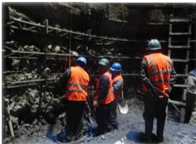
Cerchas de acero
