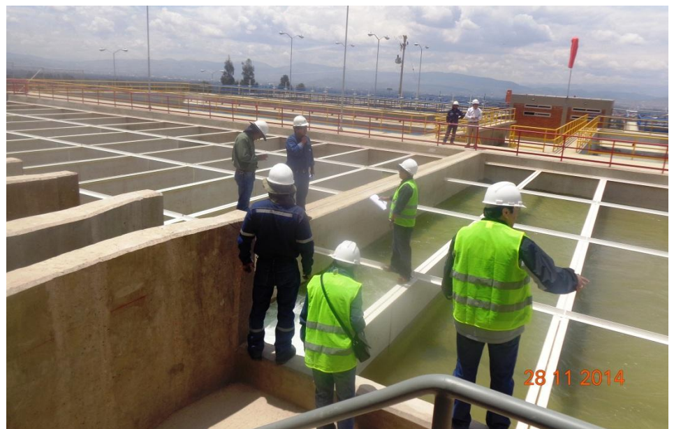
Comisión de recepción haciendo el recorrido de inspección a las obras concluidas
