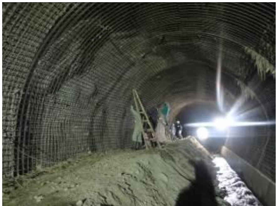
Malla electrosoldada de 10x10 cm - Ø8mm
