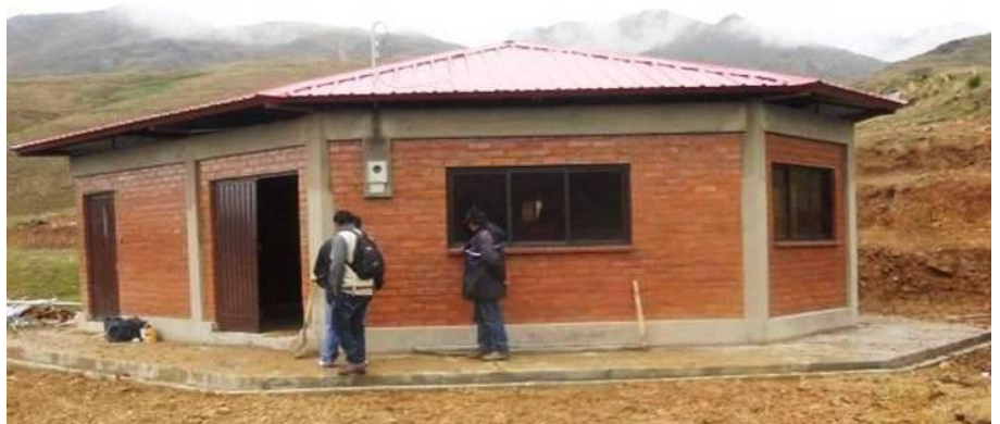
Centro de Capacidades de Misicuni II
