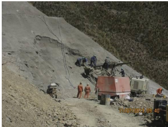
Colocado de pernos tipo A1 en el talud
