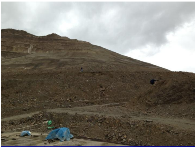
Obras paralizadas - Estribo Izquierdo, diciembre 2013
