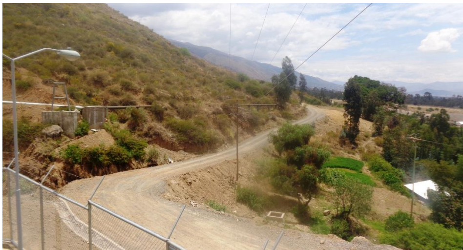
Uno de los dos caminos de acceso para la comunidad
