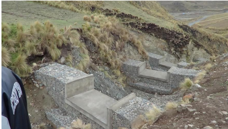
Muros de gavión en la quebrada Llano Kasa
