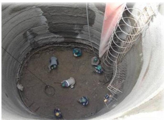
Excavación manual con martillo neumático entre cotas 3764.60 a 3727.20.
