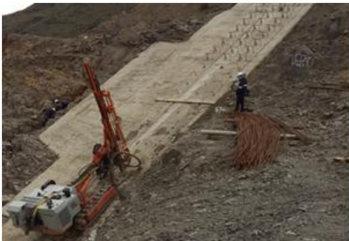
Perforación y colocado de anclajes Plinto
