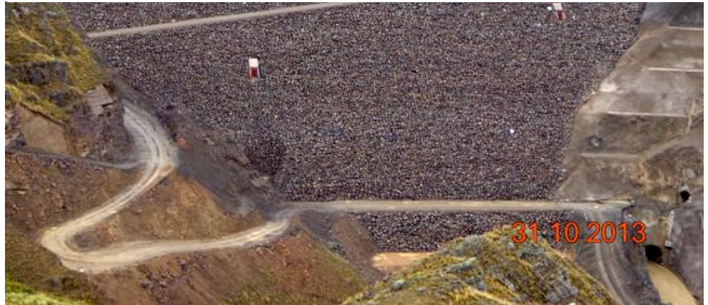
CAMINO DE ACCESO A LA GALERIA
