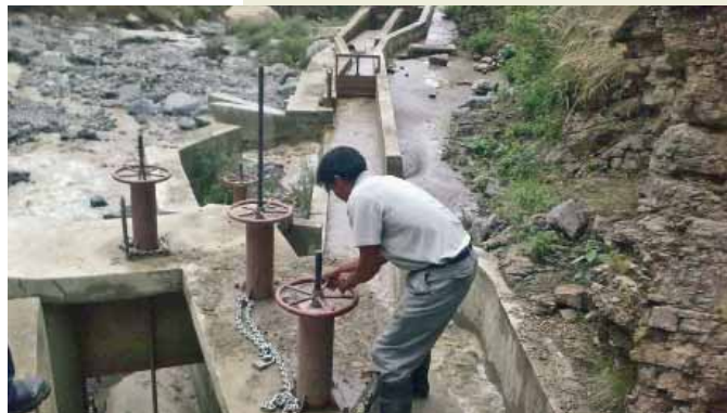
Operación Obra de Toma Malpaso noviembre 2009
