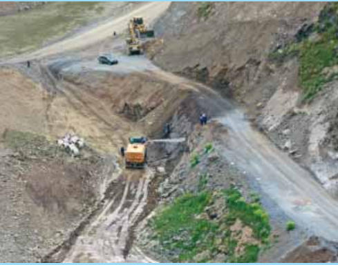
Sitio del portal de entrada del túnel de desviación
