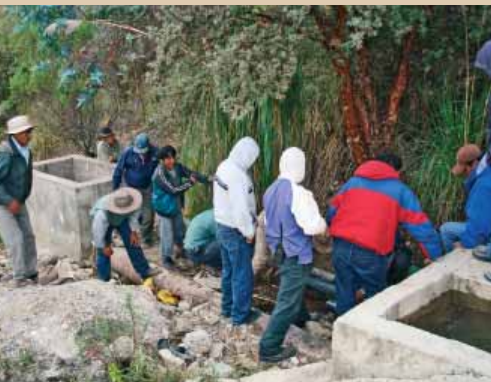
Cambio del sistema de distribución del canal abierto por tubería
