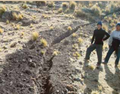
Trabajos de excavación
