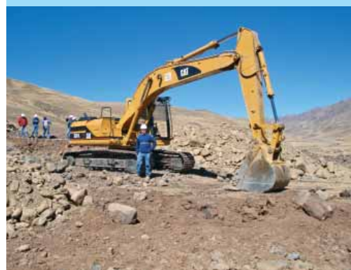
Limpieza y descapote del la zona de préstamo
