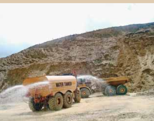
Riego de vías y sitios de obra
