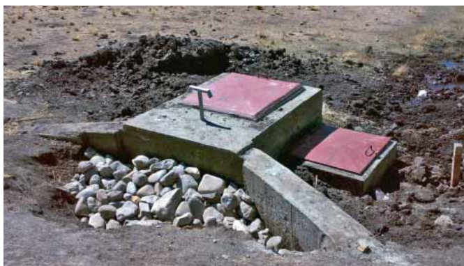
Obra de Toma Sistema de agua Khasa pampa
