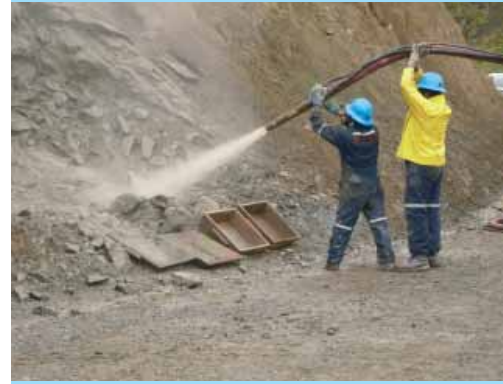
Aplicación del hormigón lanzado para pruebas
