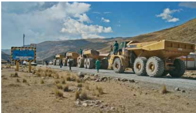
Arribo de volquetas CAT 740 a la Zona de obra
