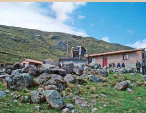
Retiro de material rocoso
