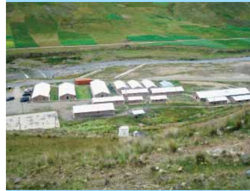
Campamento provisional concluido
