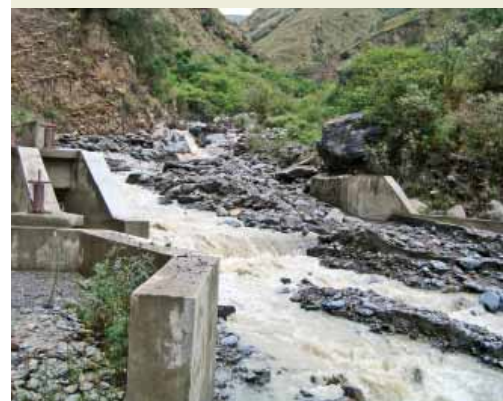
Riada en la obra de toma Malpaso
