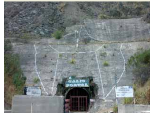
Replanteo Modificación Portal Calio
