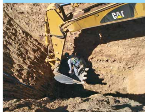
Excavación de calicatas
