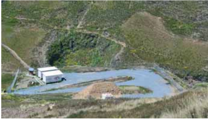
Instalaciones del polvorín
