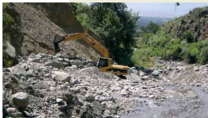
MANTENIMIENTO: Trabajos de mantenimiento quebrada Malpaso
