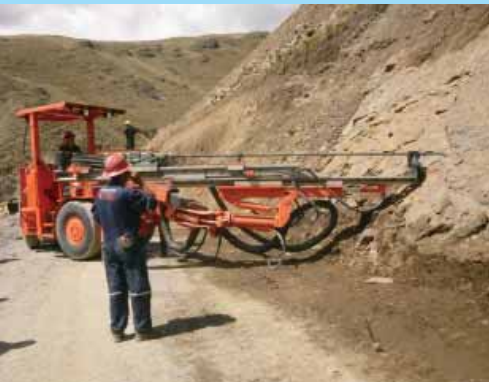
Pruebas de perforación con Jumbo
