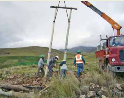
Reemplazo de torres línea de media Tensión
