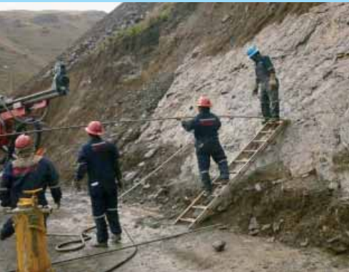
Instalación de Pernos de anclaje
