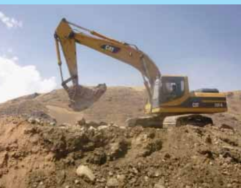
Excavaciones estribo izquierdo
