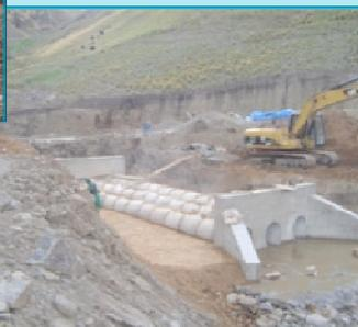
En el presente periodo se está ejecutando los trabajos de corte de taludes y en el estribo izquierdo de la presa, del sector de acceso al túnel de descarga de fondo y los caminos de acceso a los frentes y del camino principal definitivo hacia la cresta de la presa y la población de Icarí.
