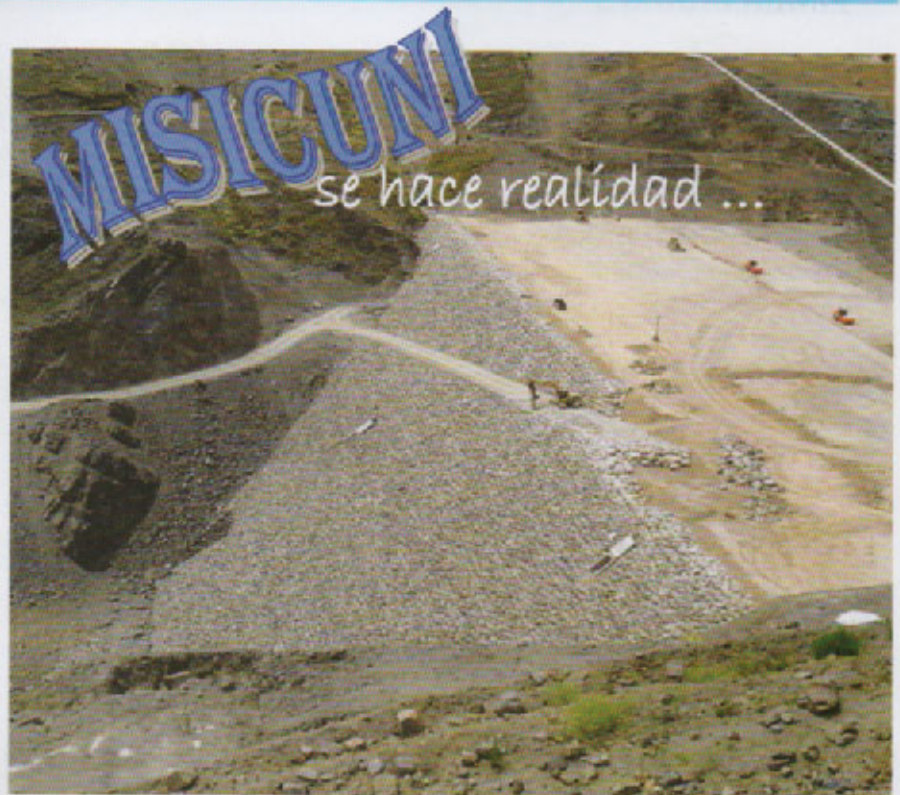
Enrocado de protección, sector espaldón de la presa
