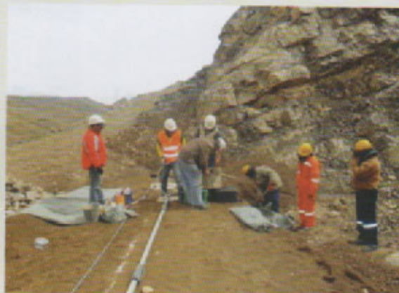
INSTALACIÓN CELDAS DE ASENTAMIENTO Y EXTENSÓMETROS DE HILO VIBRÁTIL.
