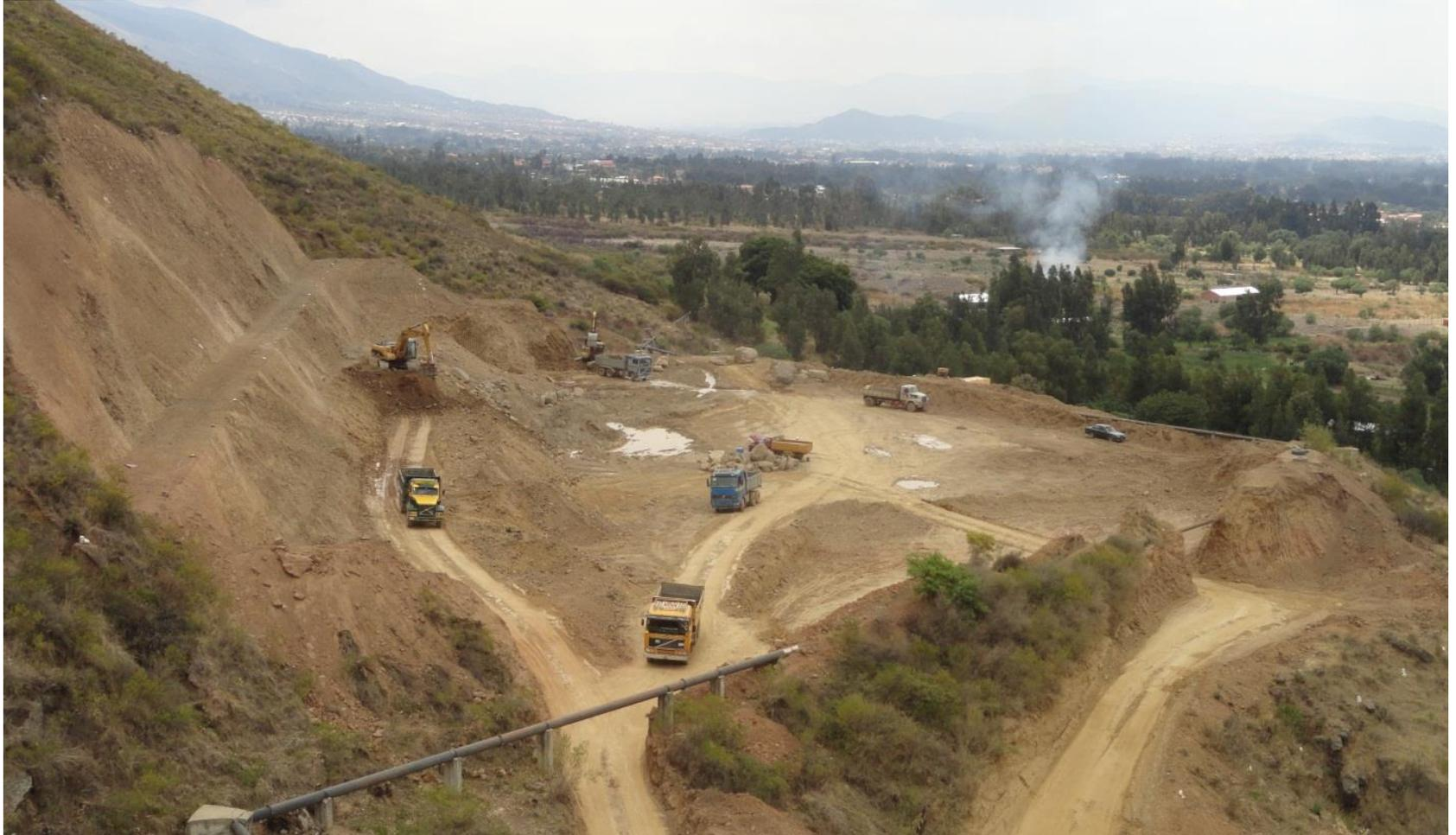
CONFORMACIÓN DE LA BANQUINA EN EL TALUD A NIVEL 2740 M. S. N. M.
