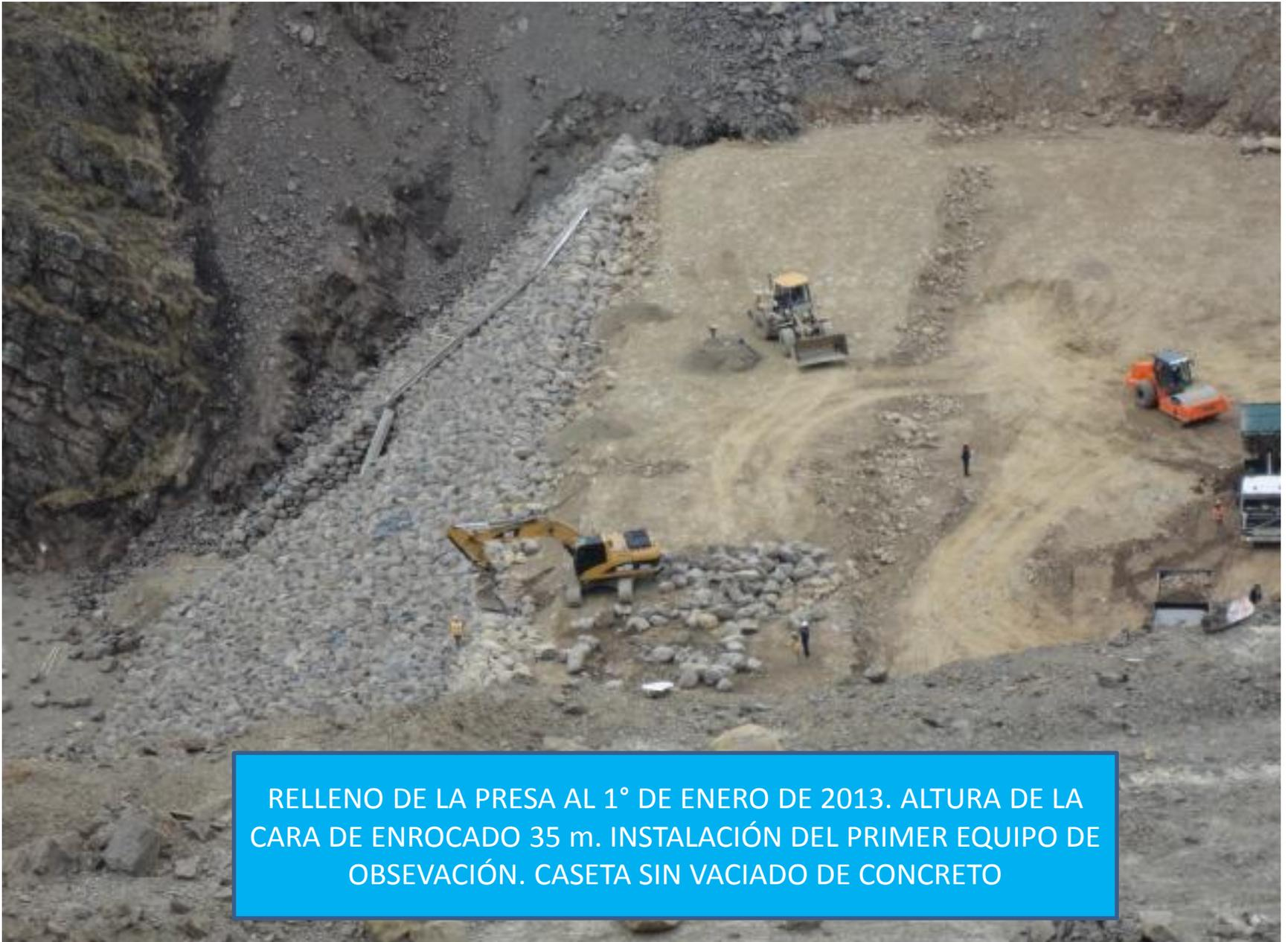
RELLENO DE LA PRESA AL 1° DE ENERO DE 2013. ALTURA DE LA CARA DE ENROCADO 35 m. INSTALACIÓN DEL PRIMER EQUIPO DE OBSERVACIÓN. CASETA SIN VACIADO DE CONCRETO
