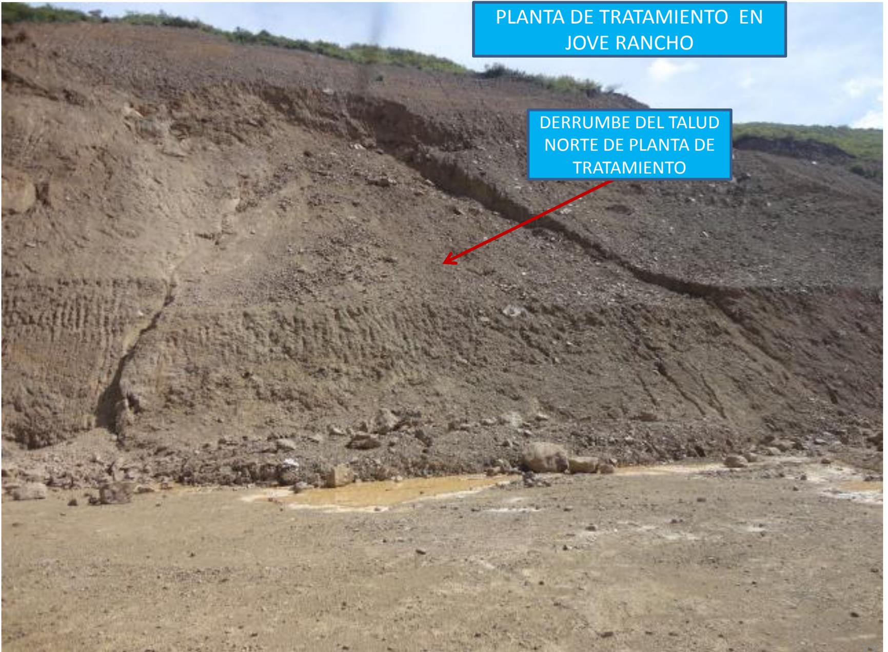
FILTRACIONES DE AGUA DE LLUVIA EN EL TALUD NORTE DE LA PLANTA DE TRATAMIENTO
