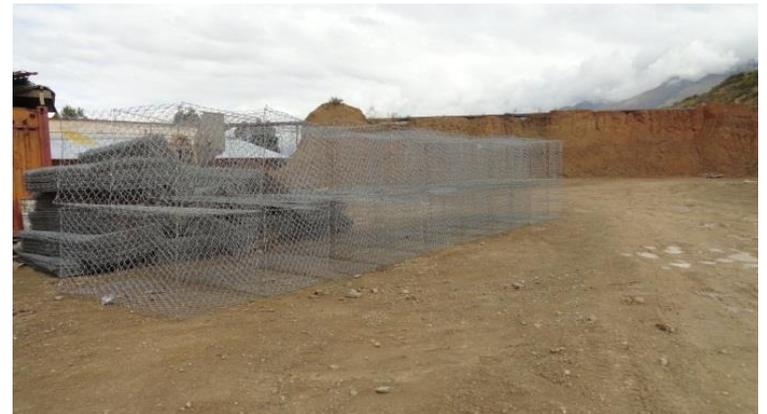
**PREPARACIÓN GAVIONES, PROTECCIÓN TALUD**
