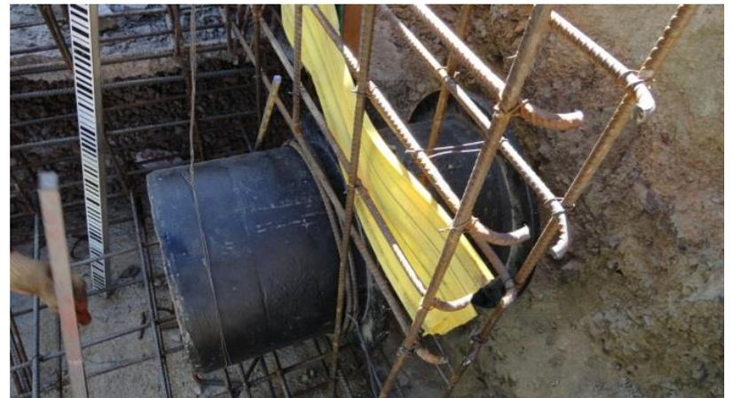
**PASA MURO INSTALADO DN 500 mm**
