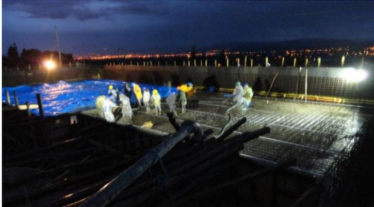
**COLOCACIÓN CONCRETO H28 LOSA FLOCULADOR**
