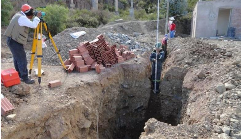
**EXCAVACIÓN DRENAJE SANITARIO VIVIENDA OPERADORES**
