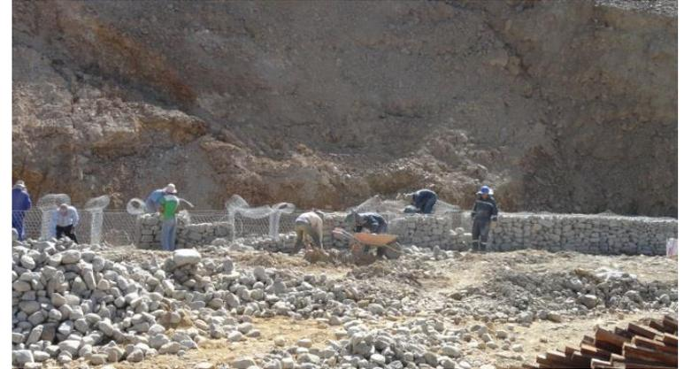
**ARMADO DE GAVIONES, PROTECCION TALUD**
