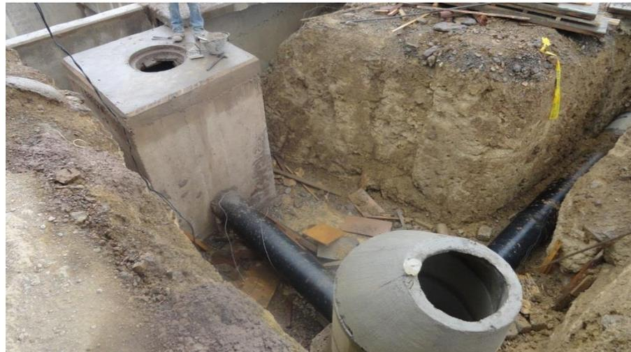
**HORMIGÓN CÁMARA VÁLVULA FLOC.1 Y CÁMARA INSPECCIÓN**
