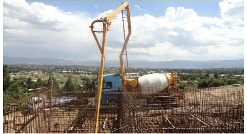
**COLOCADO H28 EN LOSA DE FONDO FILTRO 1**
