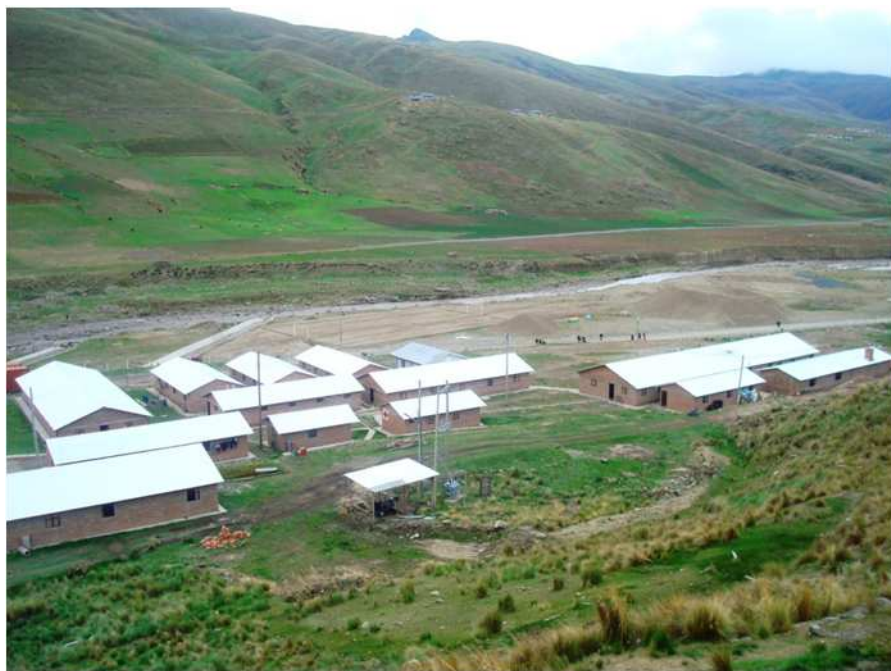
Campamento provisional Cap. 300 personas
