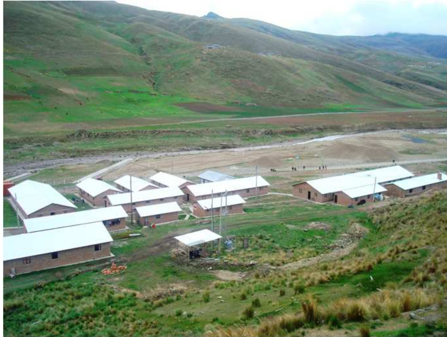
Campamento provisional Cap. 300 personas
