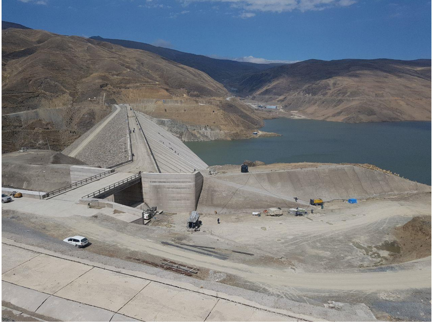
PUENTE SOBRE EL VERTEDERO
