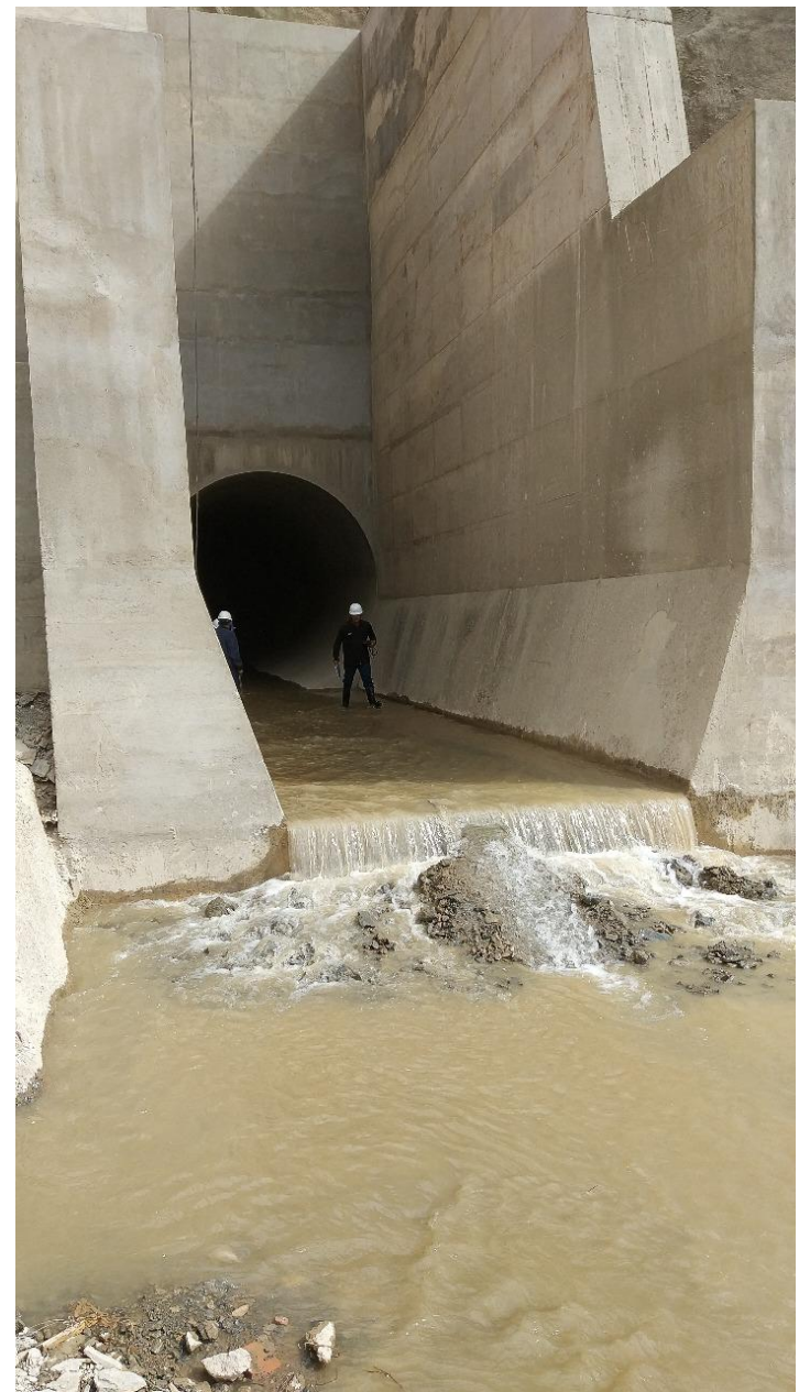
PORTAL DE SALIDA TÚNEL DE DESVÍO
