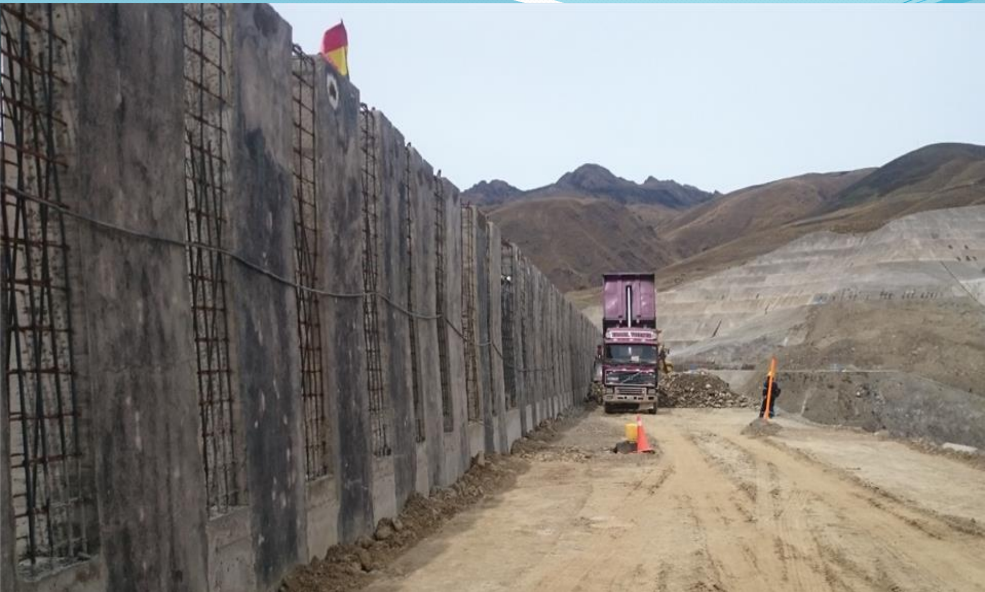
RELLENO Y CONSTRUCCION DE PARAPETO EN CORONA DE LA PRESA
