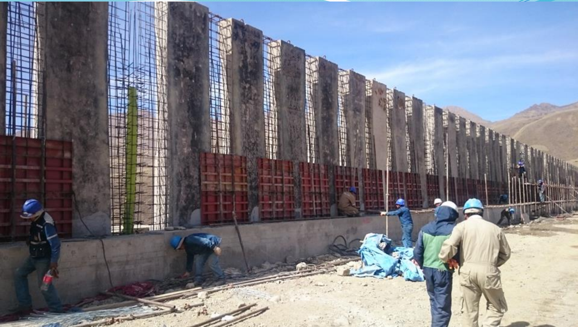
HORMIGONADO ENTRE PARAPETOS
