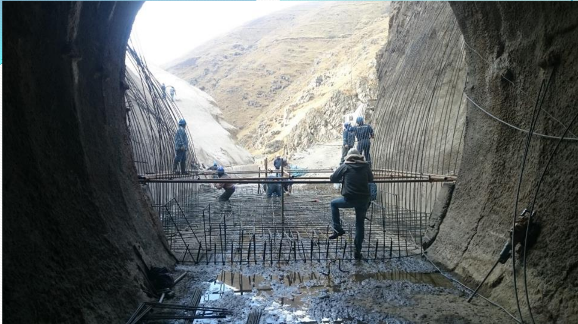
ESTRUCTURA DE SALIDA TÚNEL DE DESVÍO
